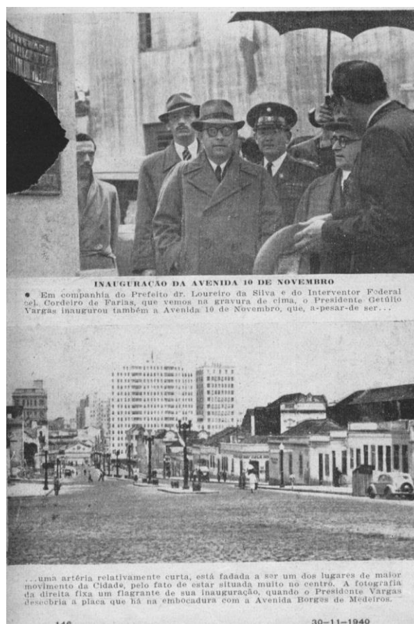
Figura 6- “Inauguração da Avenida 10 de Novembro”
