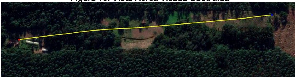
Figura 10: Vista Aérea Visada Obstruída
