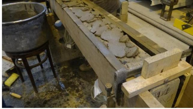
**Figura 68** – Argamassa sendo pressionada contra a viga.
