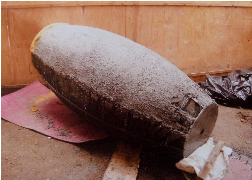
FIGURA 21 - Aplicação de massa cimentícea sobre malha de aço.
