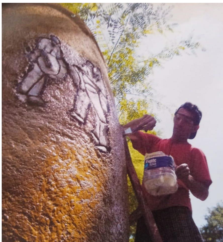
FIGURA 28 - Hamilton Carmona aplicando o verniz anti-pichação.
