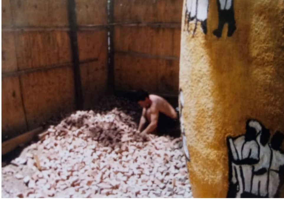
FIGURA 25 - Assentamento das pedras do piso.
