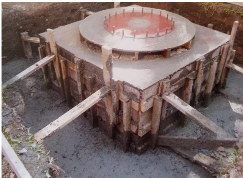
FIGURA 19 - Bloco de Fundação.
