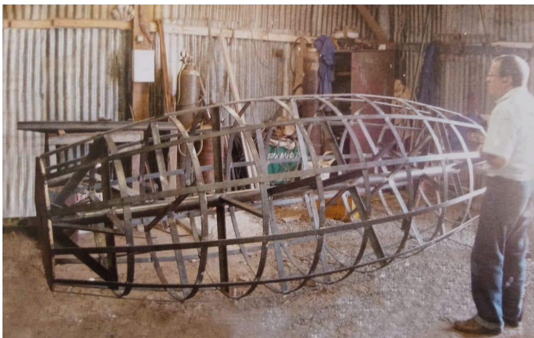
FIGURA 20 - Antonio Motter verificando a estrutura metálica.
