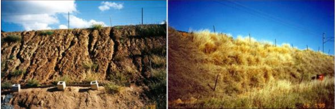
FIGURA 1 - Talude rodoviário antes e após o plantio da espécie Chrysopogon zizanioides , observando-se o efeito da vegetação quanto ao controle de erosão junto às faces dos taludes.
