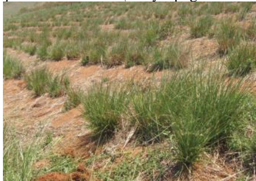
FIGURA 14 - Talude com plantio de Vetiver ( Chrysopogon Zizanioides ).
