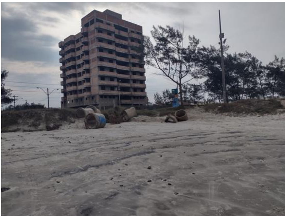
Figura 29 - Prédio em construção localizado no trecho T11.
