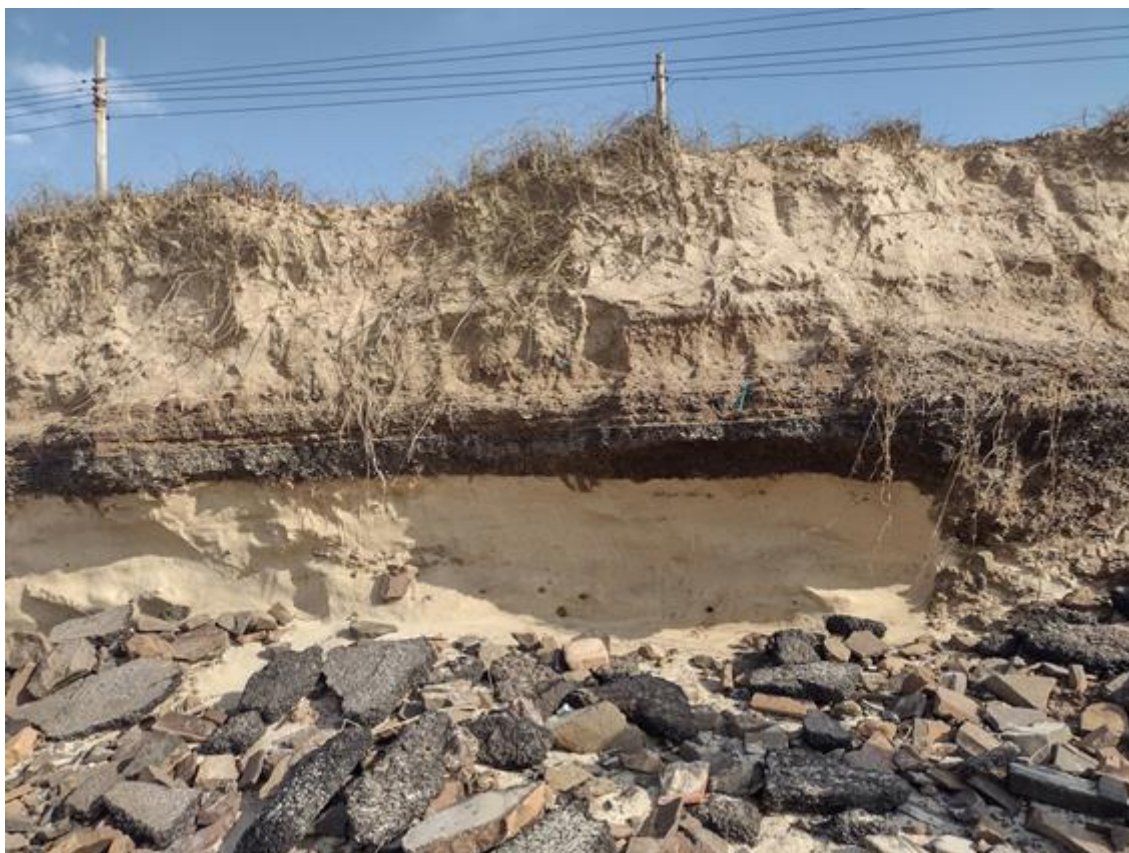
Figura 15 - Asfalto da antiga interpraias aflorando no trecho T1 após processos erosivos.
