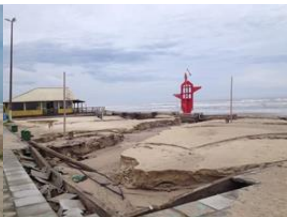
Figura 18 - Sequência histórica de processos erosivos no calçadão em Atlântida Sul.
