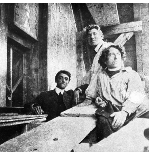
Figura 53. Le Corbusier, ao centro, com seus amigos Octave Matthey (à esquerda) e Louis Houriet (direita) durante a construção da Villa Fallet , 1907.
