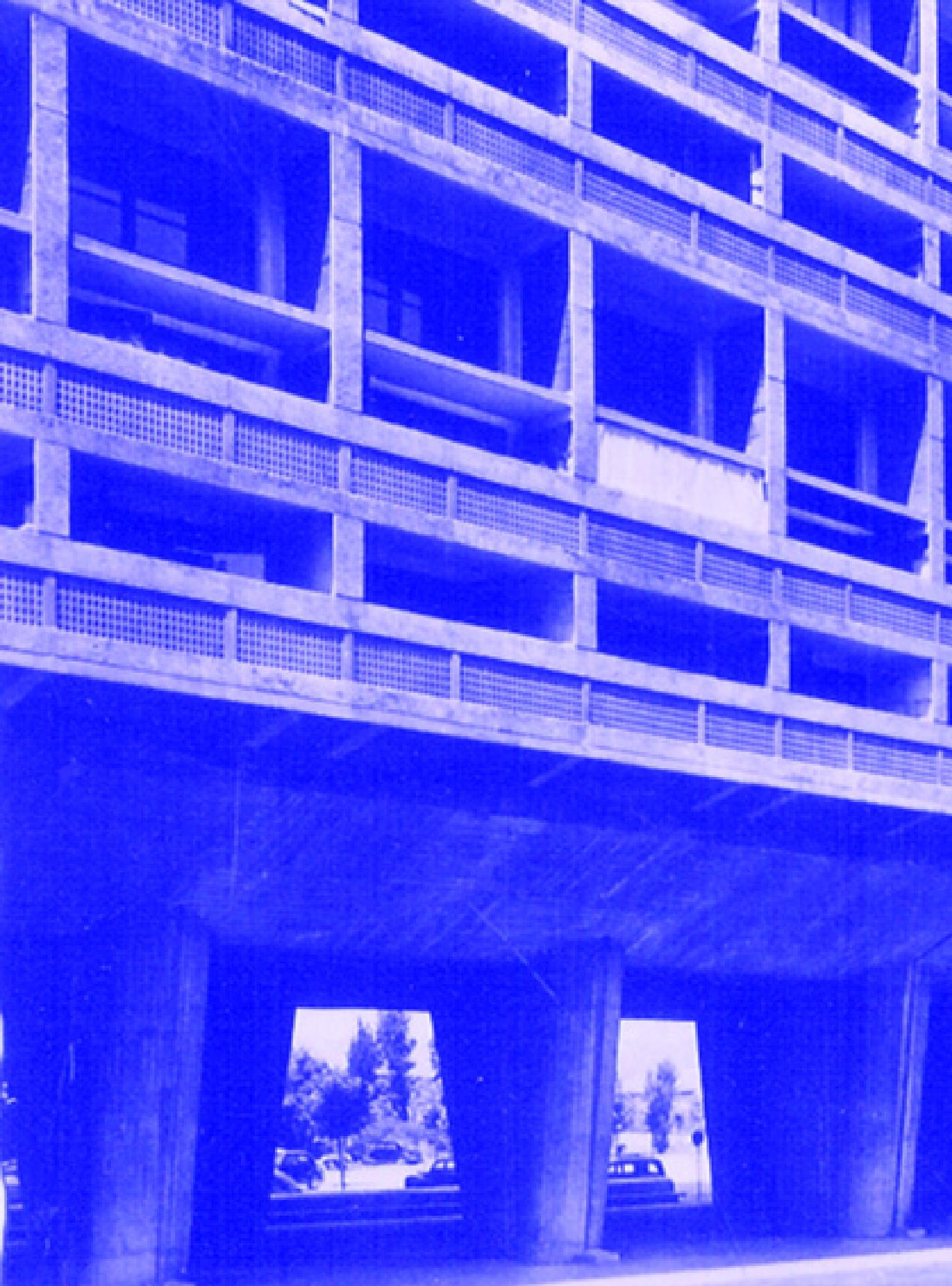
Figura 129. Fachada da Unidade Habitacional de Marseilha.
