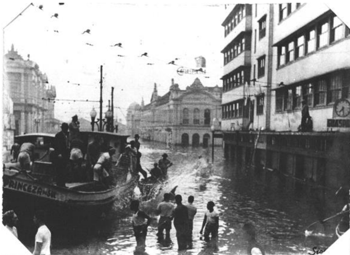
Figura 06: Águas invadiram a Avenida Borges de Medeiros e chegaram até o Edifício Guaspari.
