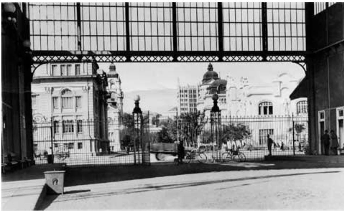
Figura 04: Vista do pórtico central do cais em direção à Praça da Alfândega. Fonte: Prefeitura de Porto Alegre.
