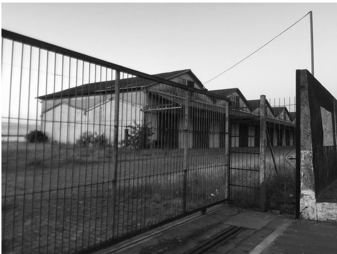
Figura 16: Armazéns encontram-se sem manutenção. Fonte: autor.
