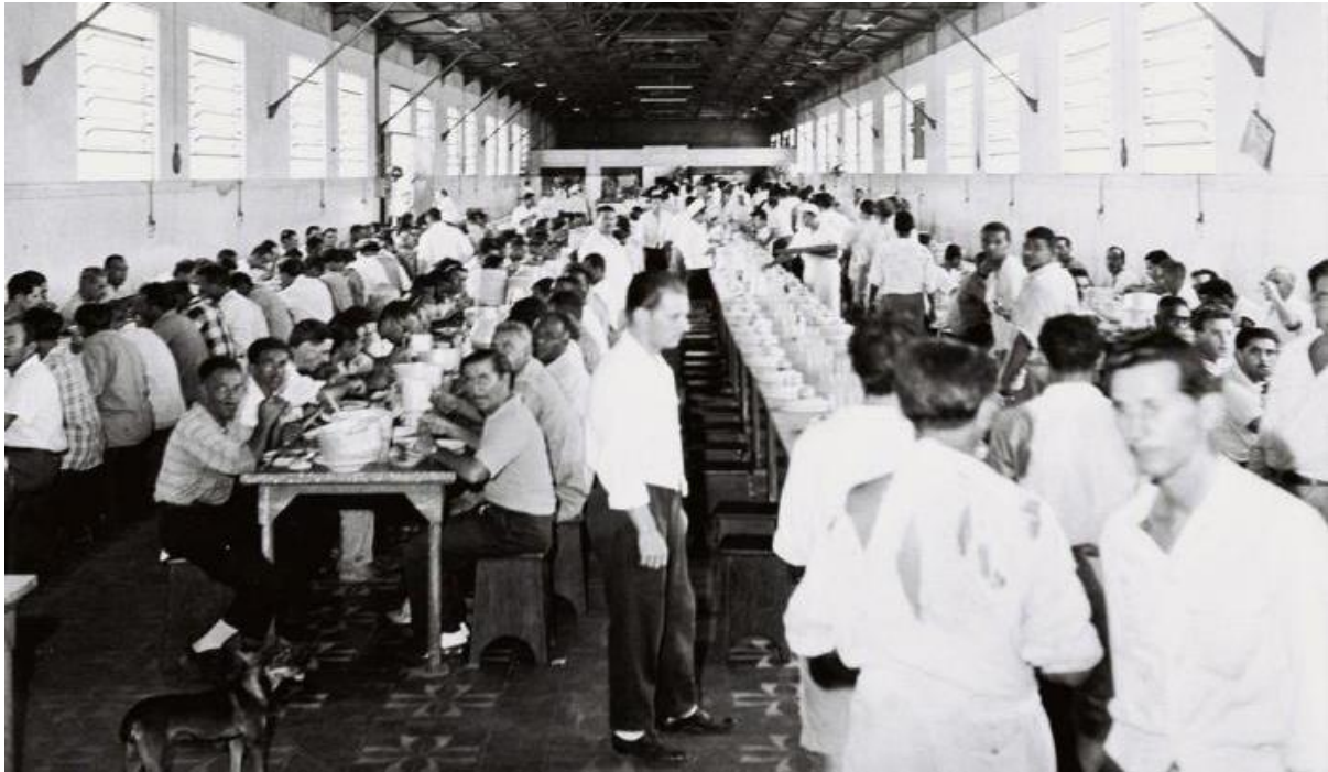
Figura 08: Refeitório do cais do porto em uso e cheio de trabalhadores. Fonte: José Abraham.
