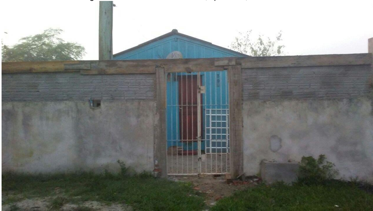
Figura 19 - Foto casa de madeira, tipo chalé, no Pestano.
