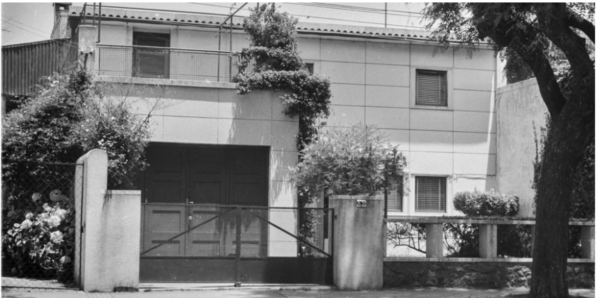
Figura 105 - Vivienda Francisco Milia construída no sistema "Vibro Econo", em 1937. Atualmente está protegida como Bien de Interés Departamental [BID], sob GPP 02. Fonte: Nómada.
