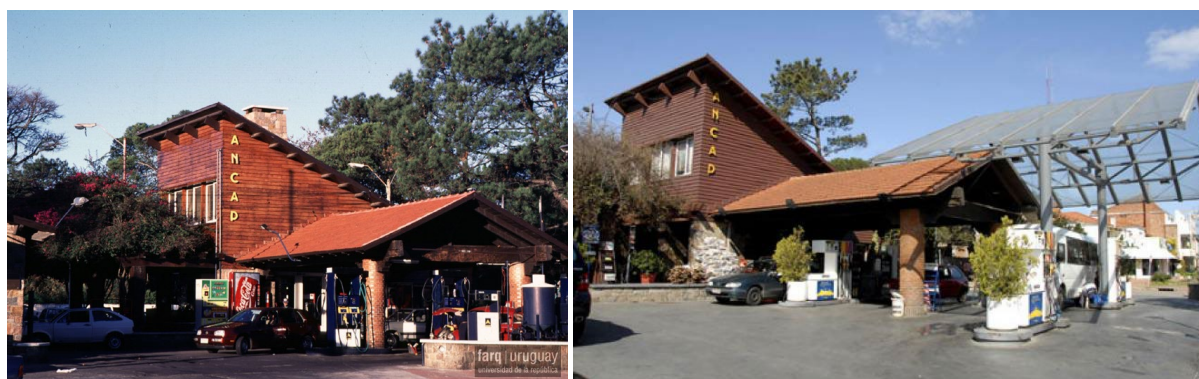
Figura 72 - Antes e depois da ampliação da área de bombas do posto da ANCAP. Fonte: FADU e Intendencia de Montevideo. Sem Data.
