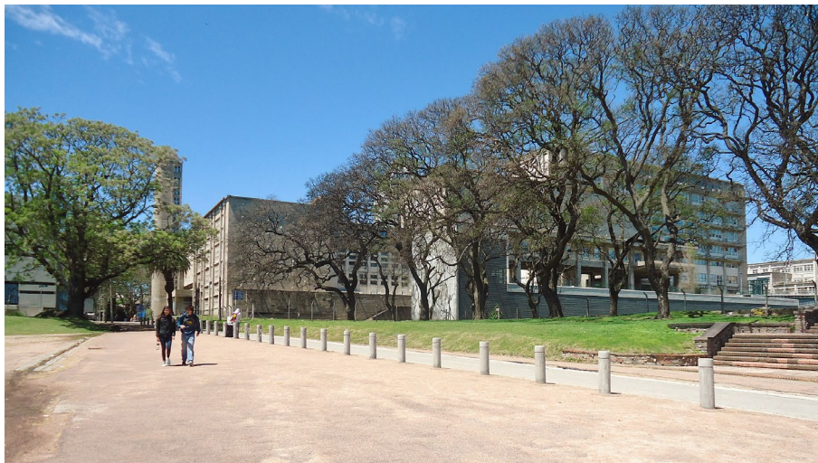
Figura 145 - Instituto de Computación e a preexistência vistos da peatonal. Autor: Luis Henrique Haas Luccas. Ano: 2019.
