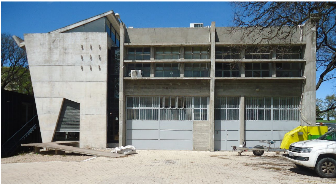
Figura 128 - Fachada do prédio anexo da Geotécnica e sua ampliação. Autor: Luis Henrique Haas Luccas. Ano: 2019.
