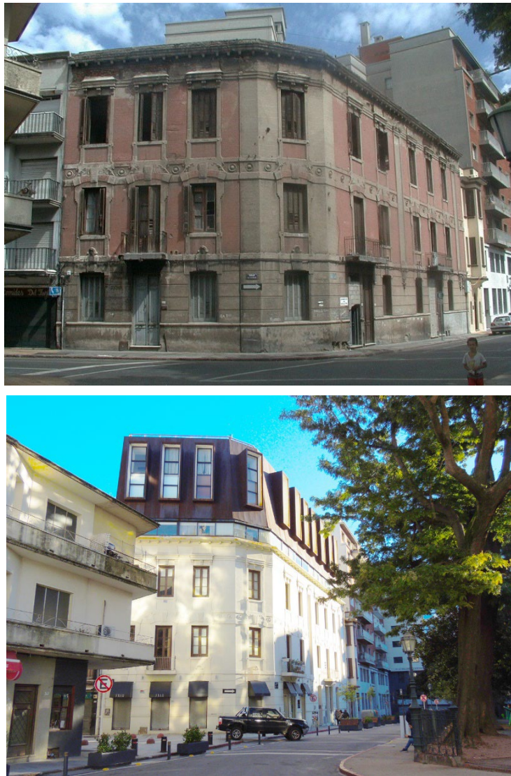
Figura 22 - Acima, foto colhida do inventário da CEPCV, estado do edifício original em 2000. Abaixo, foto do edifício em uso, em 2019. Foto da autora.
