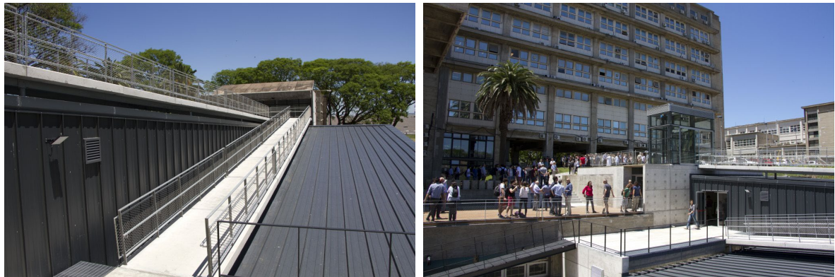
Figura 150 - À esquerda, vista da cobertura com rampa, do Edifício da IET. À direita, vista do núcleo de circulação vertical que liga o IET ao Inco. Fonte: Udelar.
