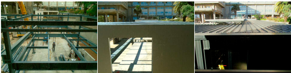
Figura 151 - Fases da construção do edifício do IET. Fonte: Boletín Mensual de Obras y Mantenimiento nº173. Ano: 2018.
