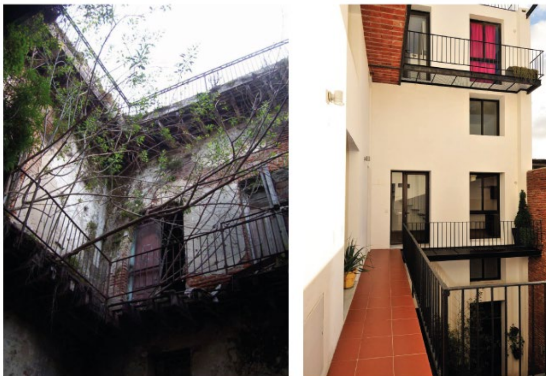
Figura 87 - Passarelas de acesso aos apartamentos – antes e depois da intervenção. Fonte: Archivo BAQ.
