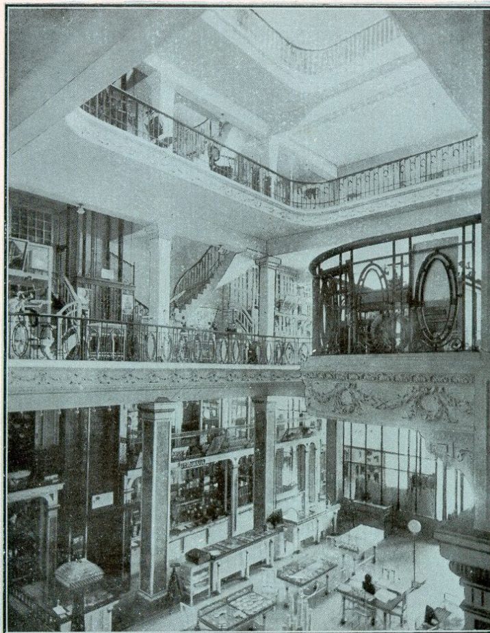
Interior lateral de los pisos superiores. Secciones Óptica y Cirujía
