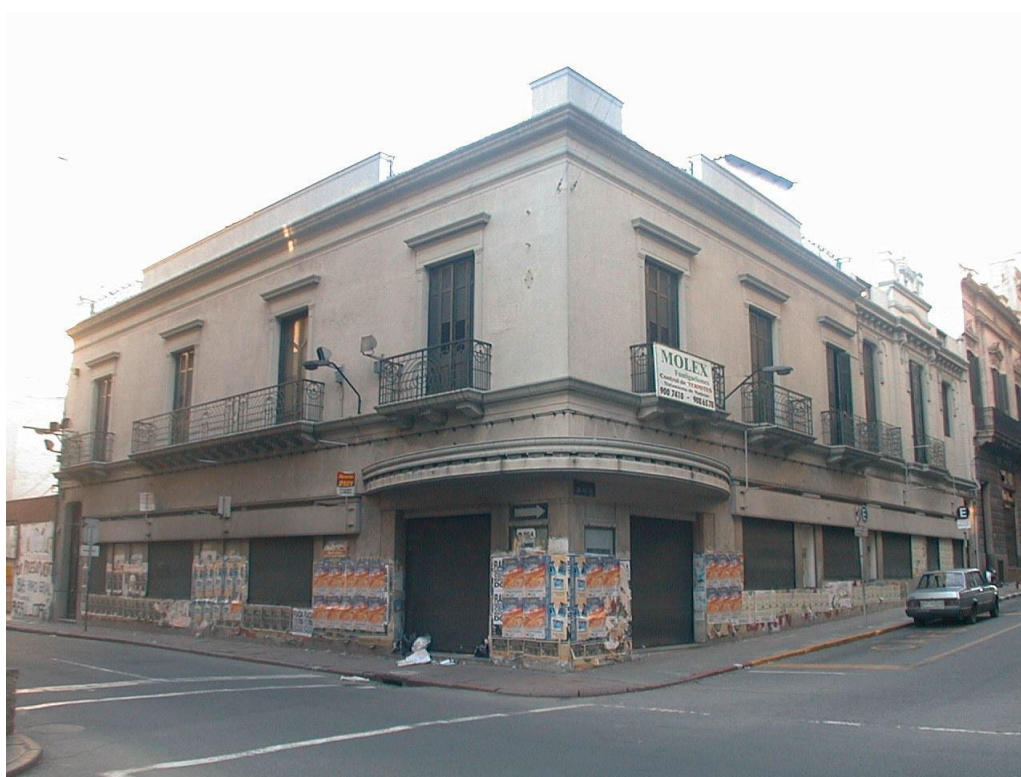
Figura 44 - Fachada do edifício em 2010, já em desuso no térreo.
