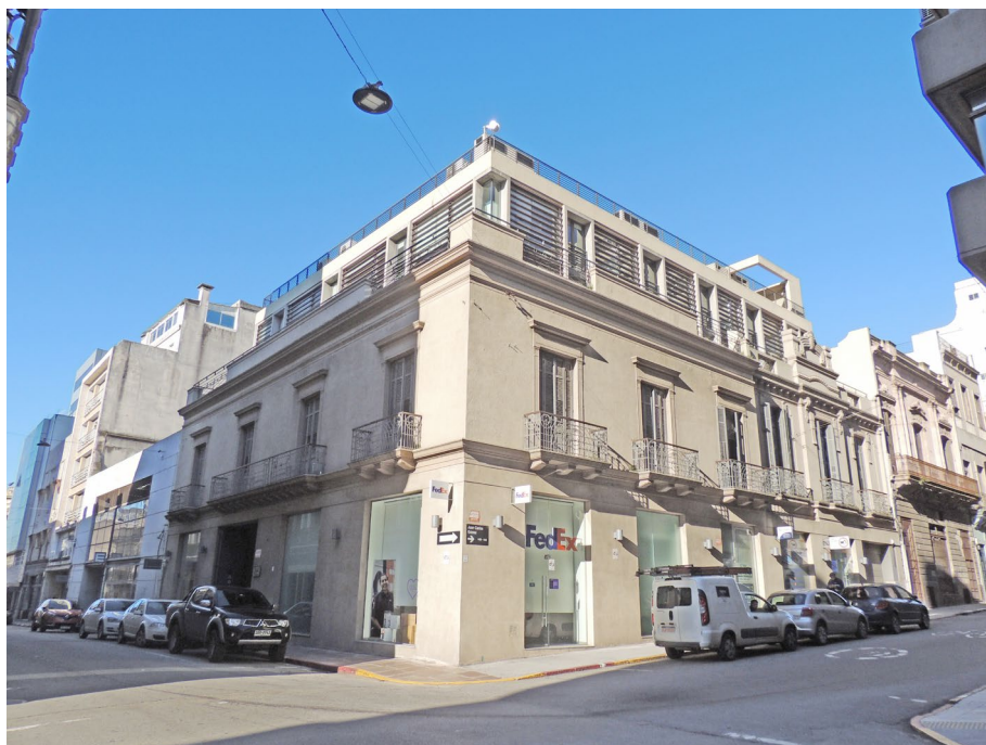
Figura 46 – Fachada do Edifício Barreiro y Ramos, agora reciclado. Fonte: Foto da autora. Ano: 2019.
