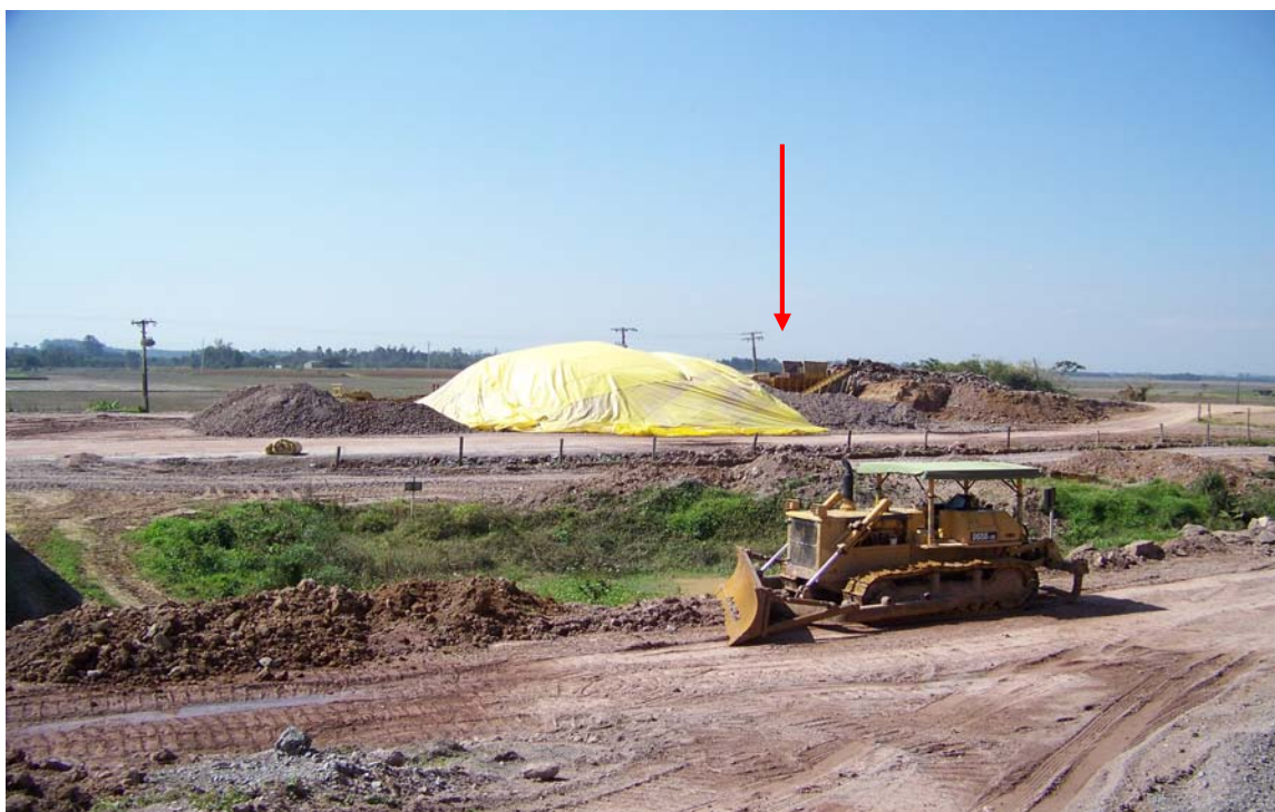
Figura 2 - Trator de esteira de lâmina frontal e escarificador na traseira, o britador ao fundo da fotografia (seta) e o lote de material em descanso sob a lona amarela. Área de manuseio do material da mina de Turvo.
