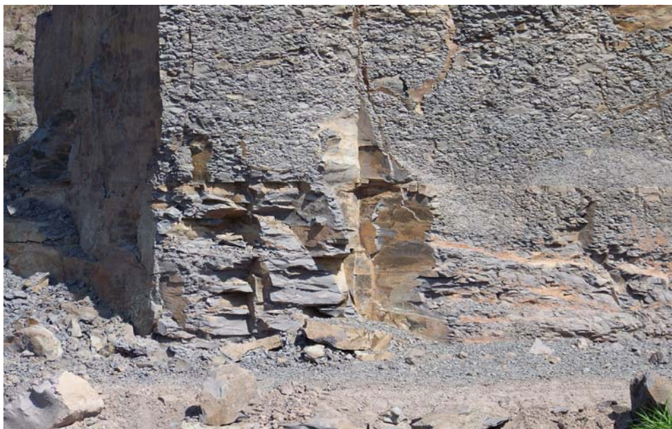
Figura 10 - Rocha cor cinza escuro com variações para marrom e fraturamento subvertical na mina de Turvo.
