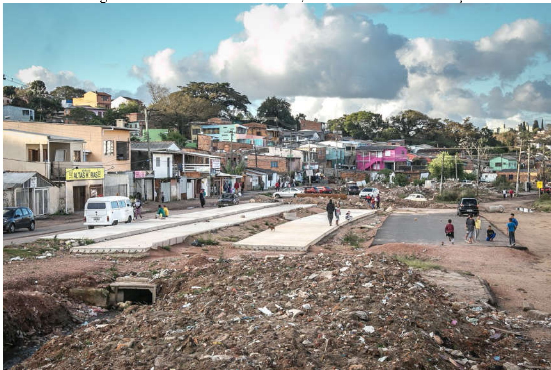
Figura 6: Avenida Tronco em 2017, com resíduos das demolições.
