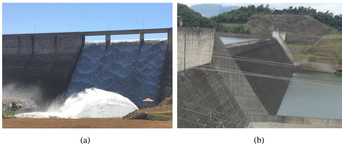
Figura 1.1. Vertedouros em Degraus: (a) Vertedouro da Barragem do Ribeirão João Leite, da SANEAGO – Saneamento de Goiás S. A., Goiânia, GO; (b) Vertedouro da Barragem da UHE Dona Francisca, do Consórcio Dona Francisca, Nova Palma, RS.
