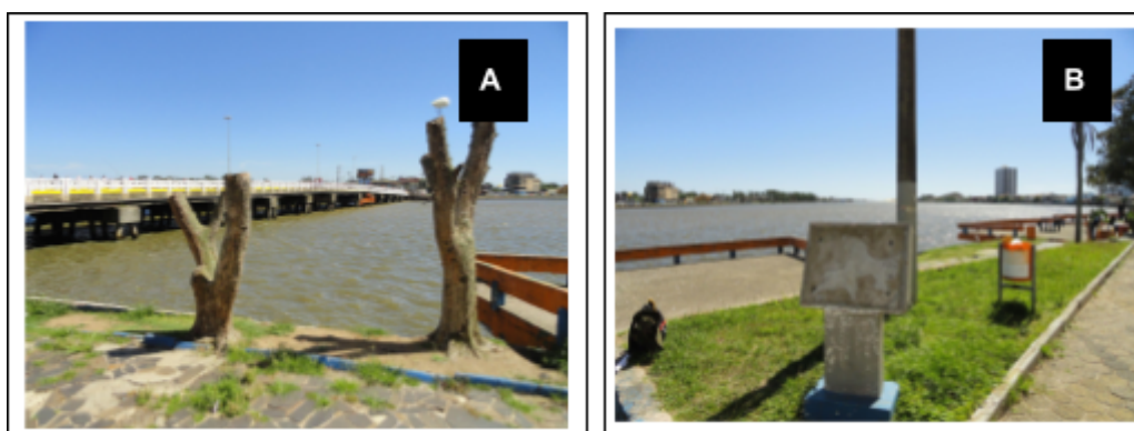
Figura 13. A) Ponte Giuseppe Garibaldi, interligando os municípios de Tramandaí e Imbé; B) Marco histórico em homenagem a Giuseppe Garibaldi, nomeando a ponte e indicando o local onde as tropas de Garibaldi retornaram ao mar. Fotos: Do autor, 2018.
