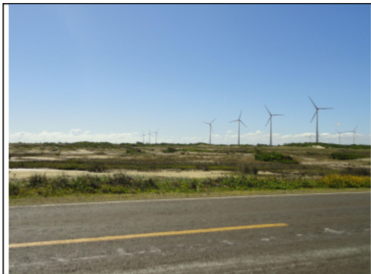
Figura 12. Parque Eólico Cidreira I, observado a partir da RS-786. Foto: Do autor, 2018.
