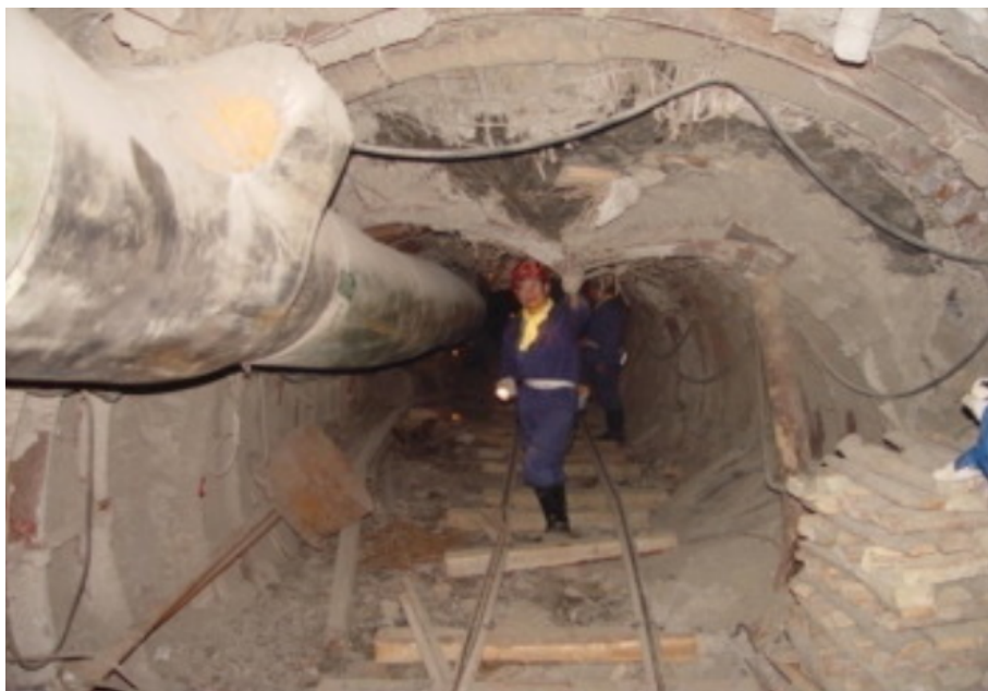
Figura 1.2 – Ruptura do suporte (perfil de aço) em uma mina de carvão na China (fonte: Manchao et al. (2015, p. 192))
