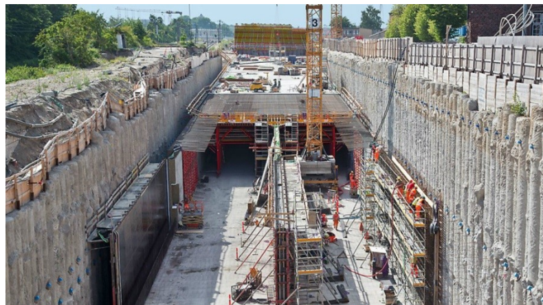
Figura 3.3 – Etapa de execução pelo método de vala recoberta direta no projeto Nordhavnsvej , em Copenhague, Dinamarca (fonte: ROADTRAFFIC-TECHNOLOGY (2017, p. 1))
