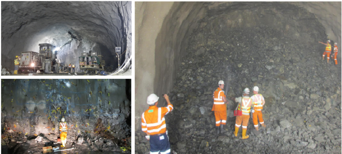
Figura 3.6 – Superior à esquerda: perfuração; inferior à esquerda: instalação das cargas; à direita: frente de escavação após detonação (fonte: Grad (2013, p. 1))
