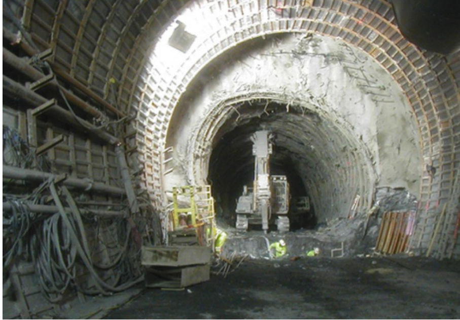
Figura 1.1 – Redução da seção transversal do Túnel de Base Lyon Turin na fronteira entre França e Itália (fonte: Barla, Bonini e Debernardi (2010, p. 41))
