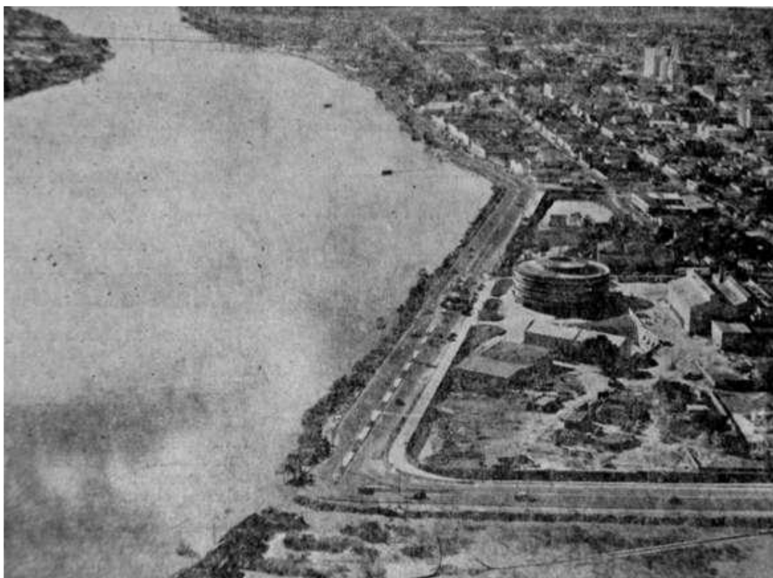
Figura 8 – Trecho da Avenida Maranhão com a Avenida Joaquim Ribeiro
