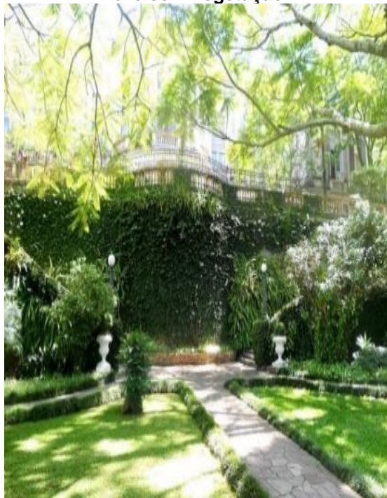
Figura 70 Muro com vegetação
