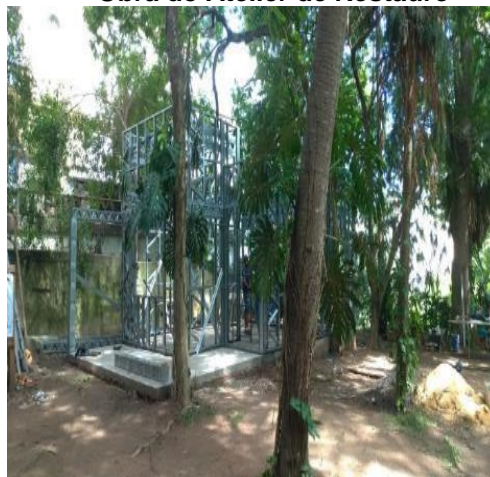
Figura 76 Obra do Atelier de Restauro
