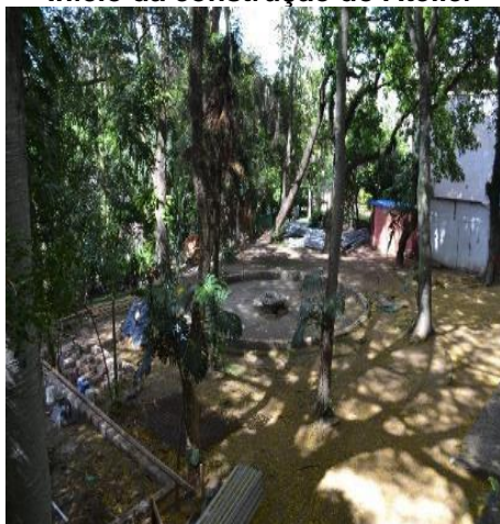
Figura 75 Início da construção do Atelier
