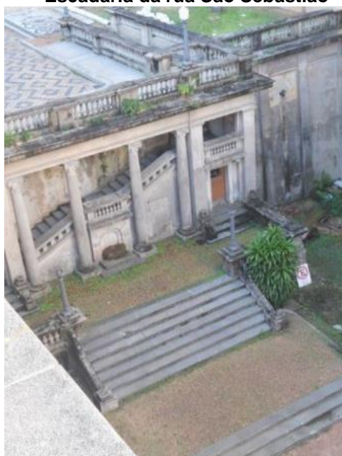
Figura 21 Escadaria da rua São Sebastião
