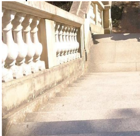
Figura 45 Guardacopos com balaustradas em cimento
