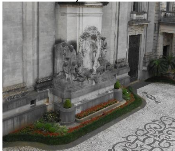
Figura 37 Modificações no canteiro
