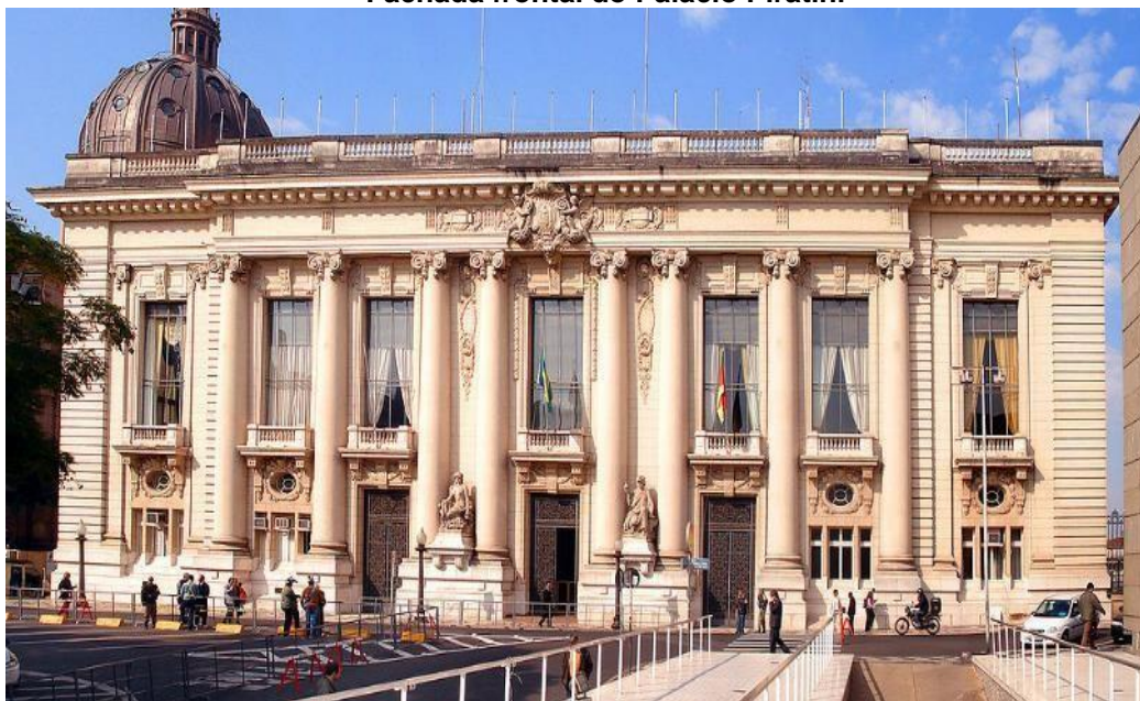
Figura 28 Fachada frontal do Palácio Piratini
