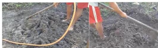
Figura 23 – Construção da casa na Tekoa Yvy Poty .
