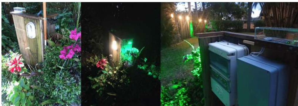
Figura 15: Instalação Iluminação vista 1.
