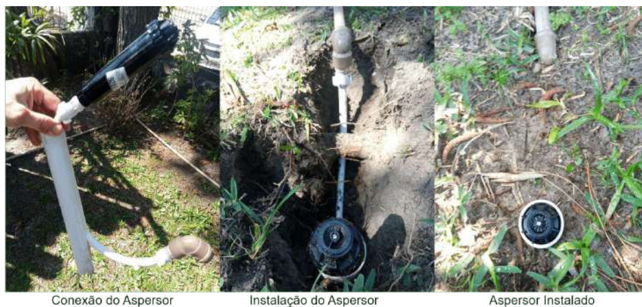
Figura 18: Instalação Aspersores
