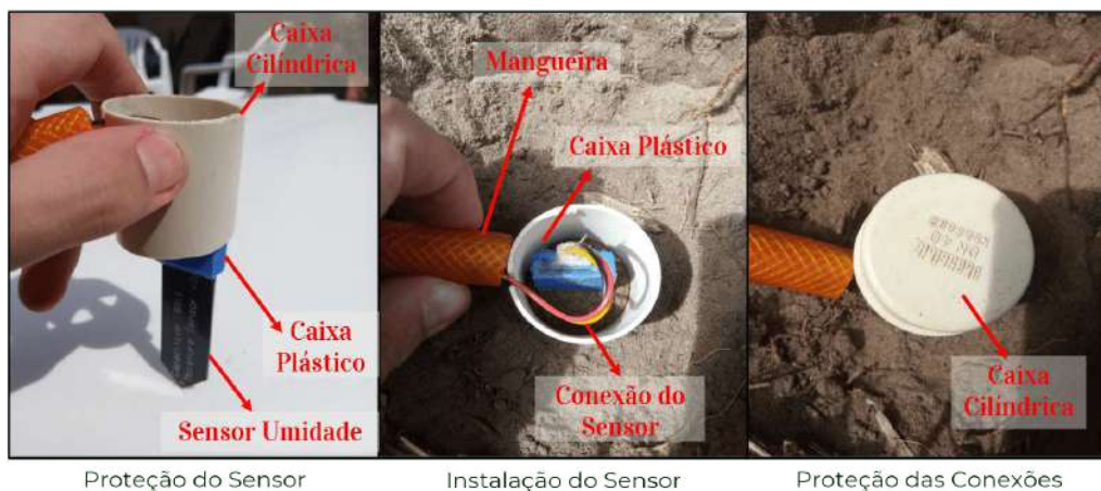
Figura 14: Instalação Sensor Umidade.
