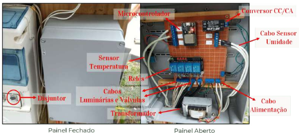
Figura 12: Instalação Painel Principal.
