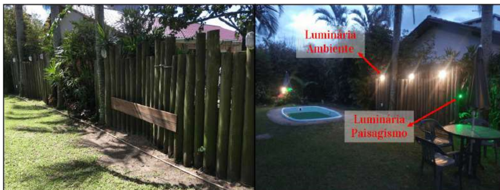
Figura 16: Instalação Iluminação vista 2.
