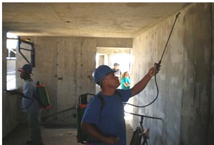
Figura 16 – Operador realizando cura de parede de concreto com uso de pulverizador
