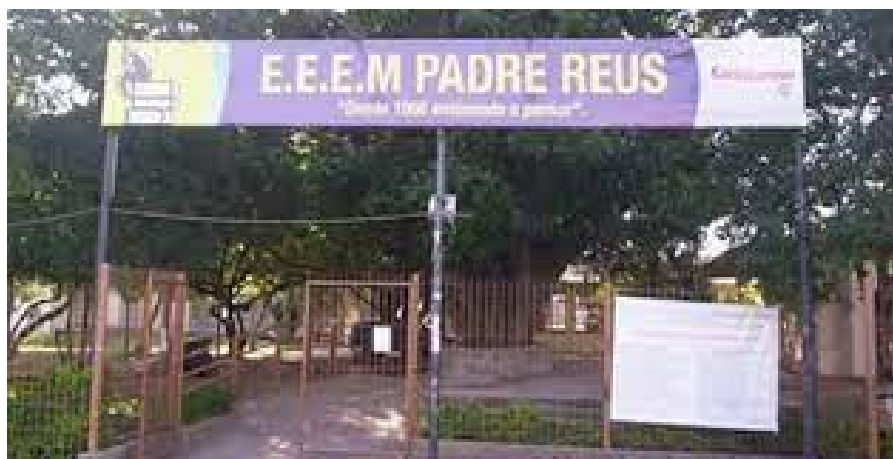
Figura 5: Fachada da escola
