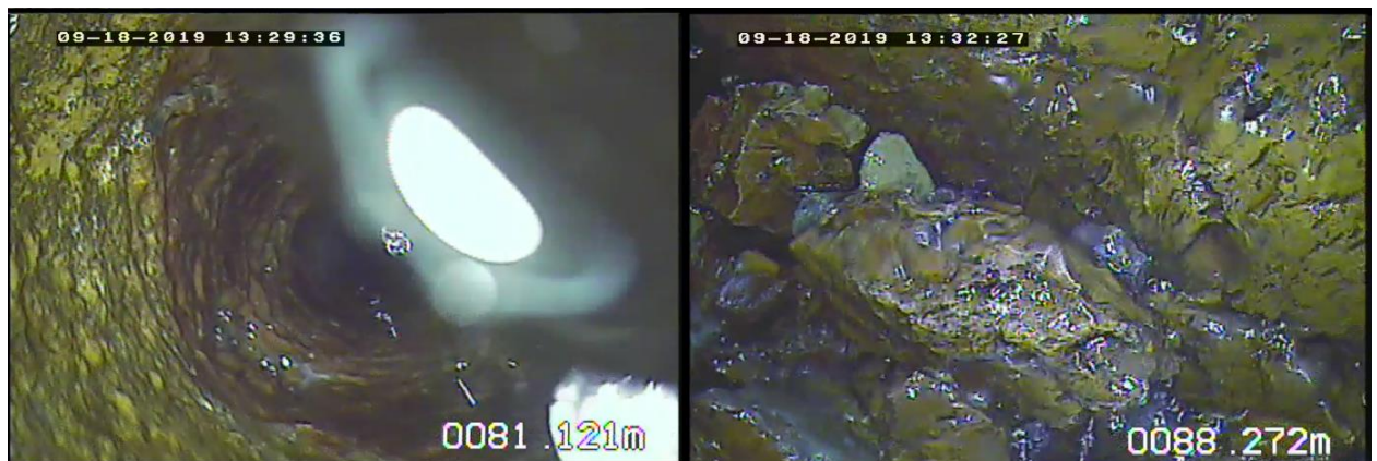
Figura 40 - Filmagem do poço 5498-FAB5, passagem para pacote fraturado e entrada de água.
