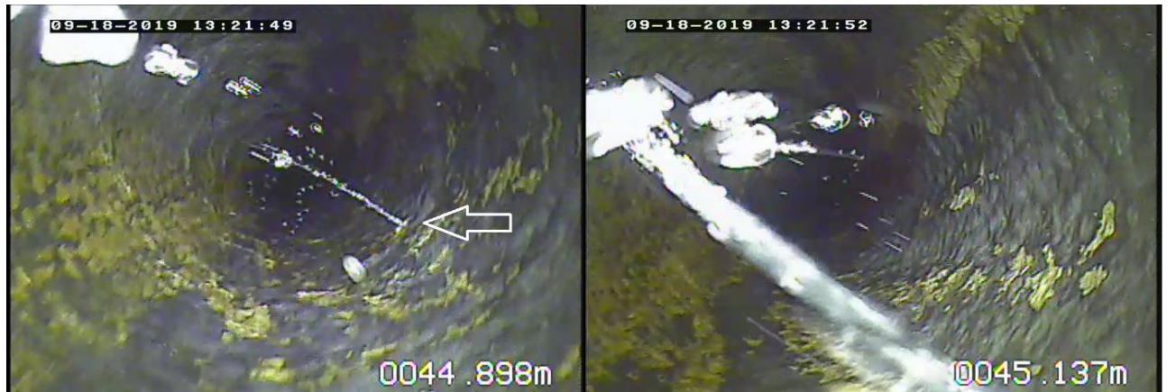
Figura 39 - Filmagem do poço 5498-FAB5, entrada de água pontual com pressão hidrostática aos 45m.
