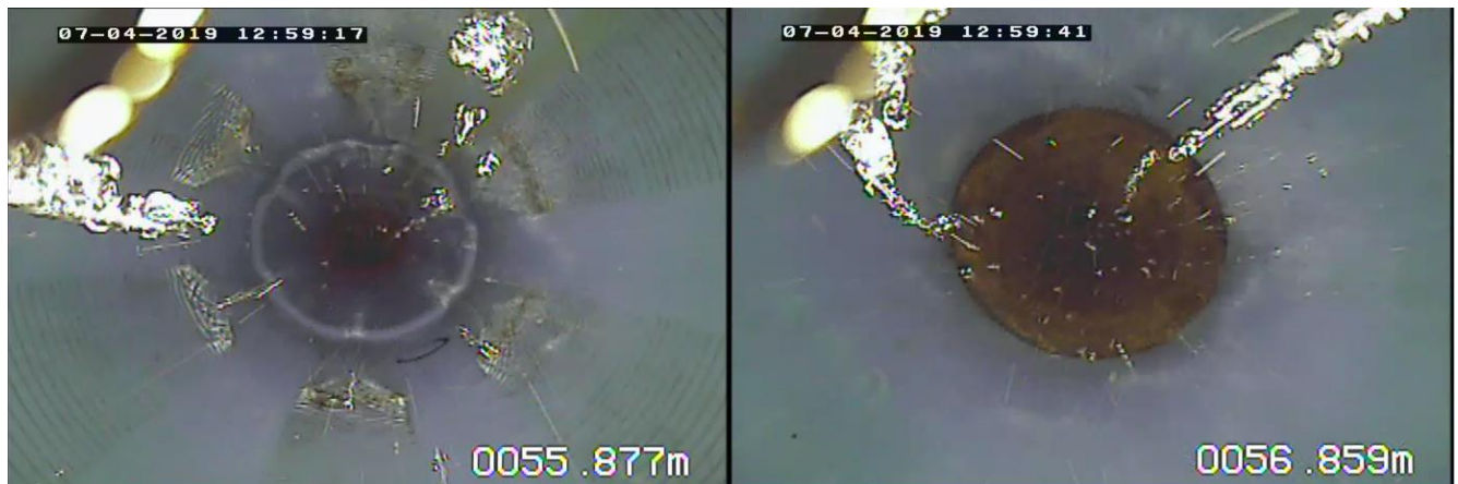
Figura 36 - Filmagem do poço GAR 12, segunda entrada de água aos 55m e fim do revestimento aos 57m.
