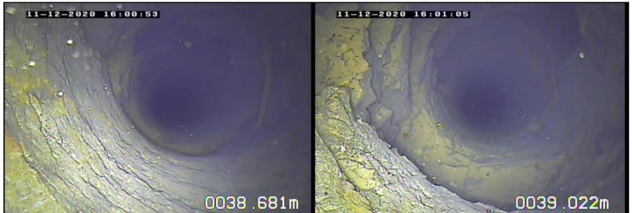
Figura 32 - Filmagem do poço COR ARV 11, mudança de pacote maciço para fraturado aos 39m.
