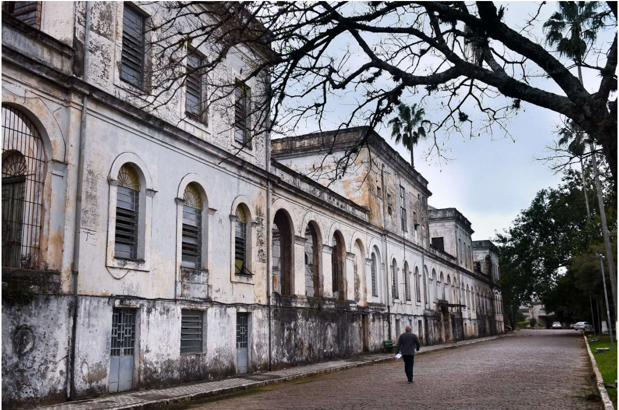
Figura 1 – Hospital Psiquiátrico São Pedro (2018)
