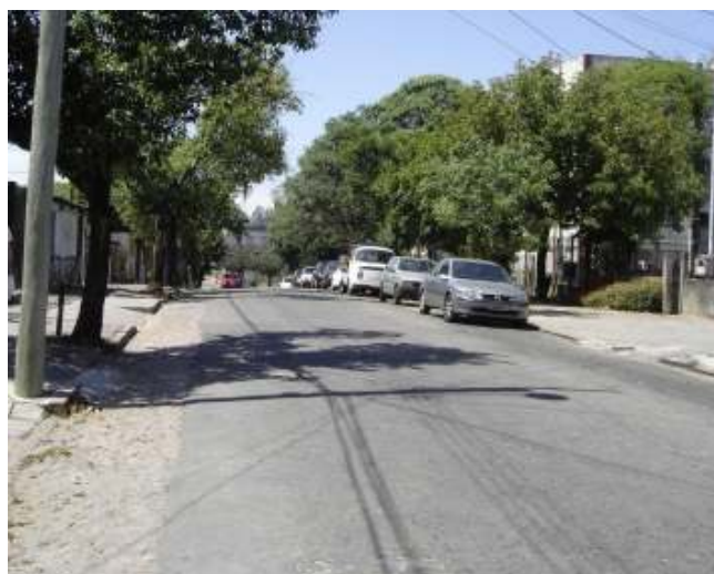
Figura 18: carros estacionados na rua João Mora sobre remendo
