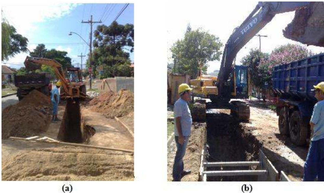
Figura 10: escavação com retroescavadeira (a) e com escavadeira (b)
