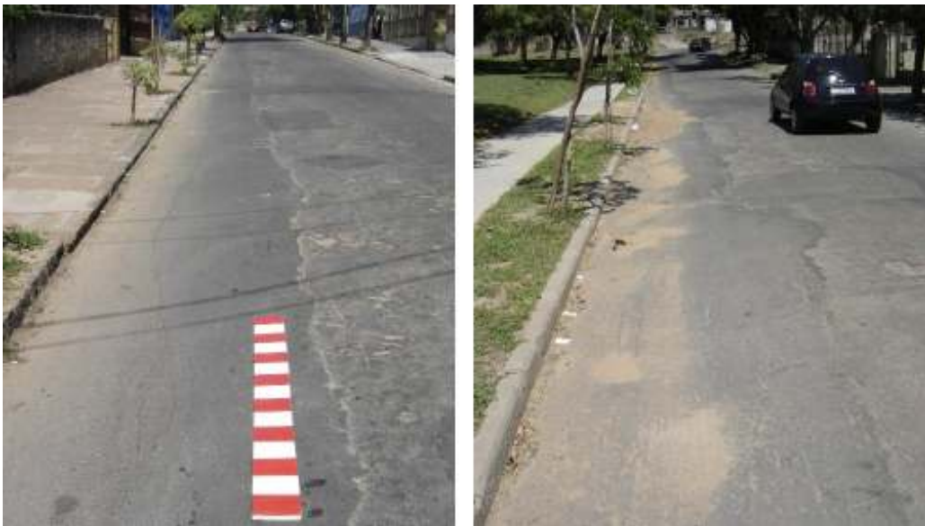
Figura 32: acabamento do concreto asfáltico para base de paralelepípedo
