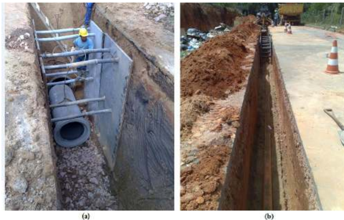
Figura 14: assentamento de tubo de concreto sobre camada de rachão (a) e assentamento de tubo de PVC sobre camada de areia (b)
