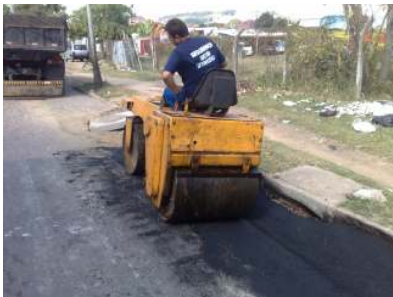
Figura 16: compactação por rolo mecânico
