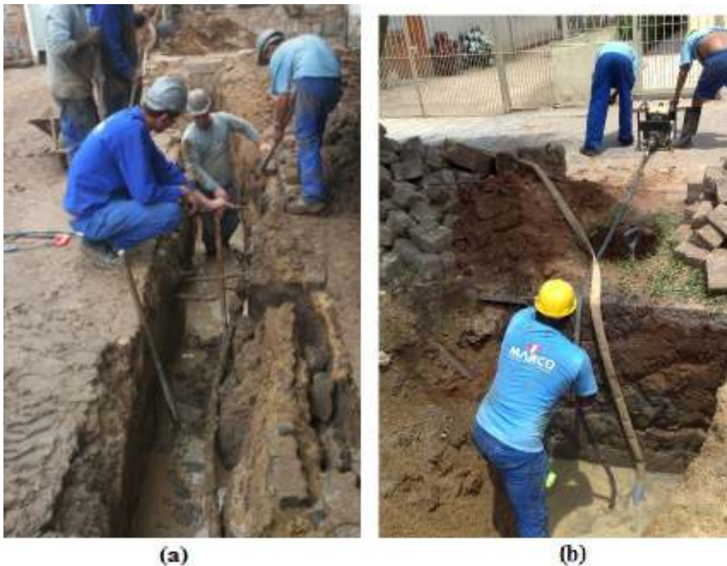
Figura 12: dificuldades de escavação com presença de água (a) e esgotamento de vala (b)
