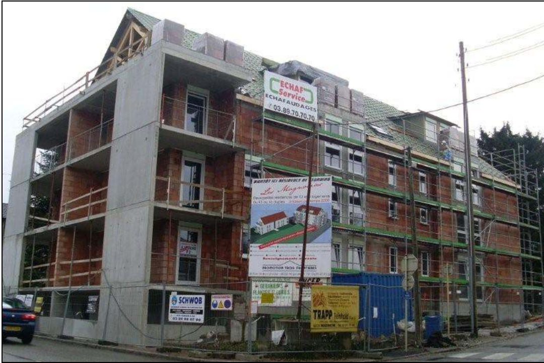
Figura 13: vista do prédio semi-acabado
