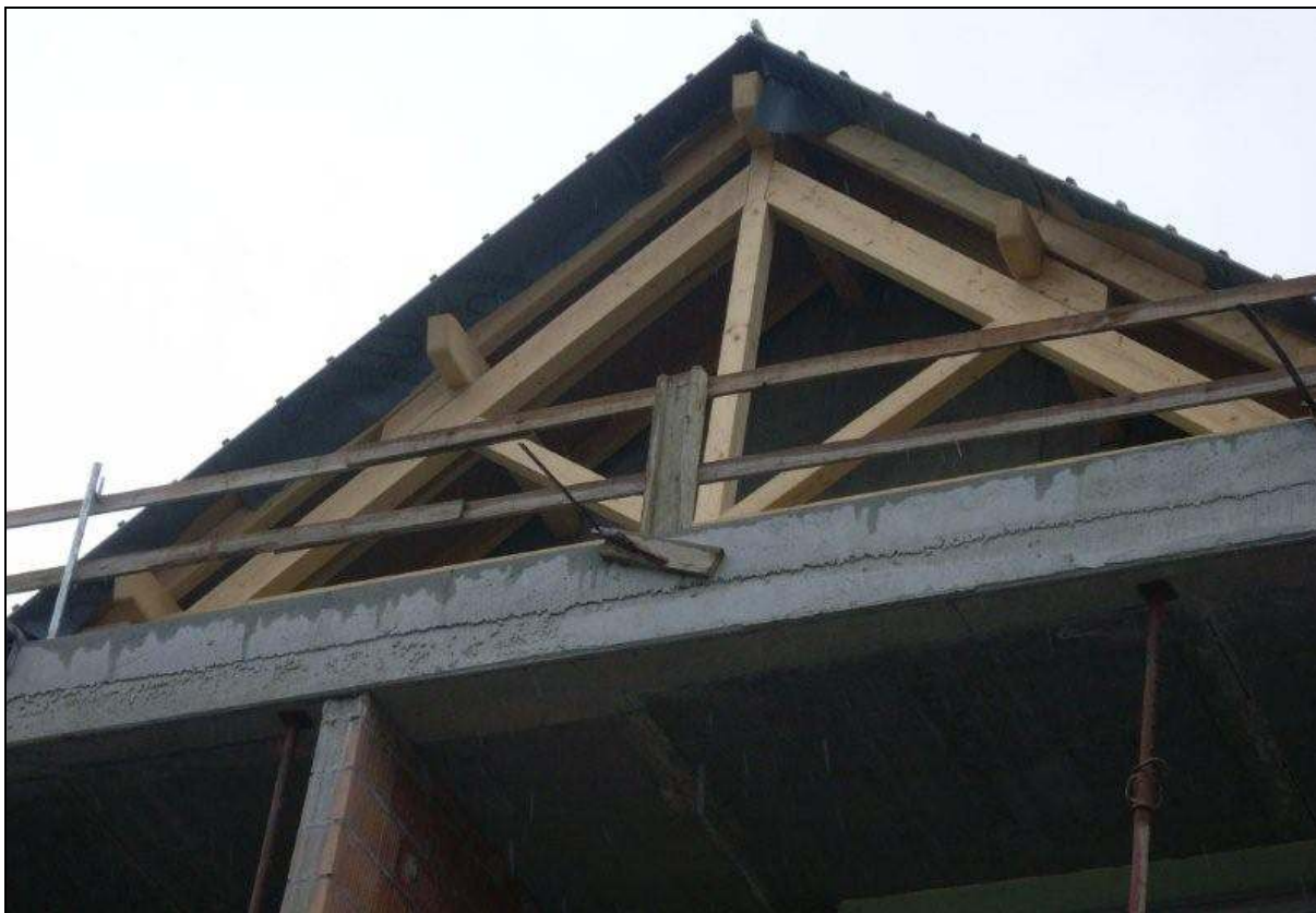
Figura 15: oitão em concreto armado
