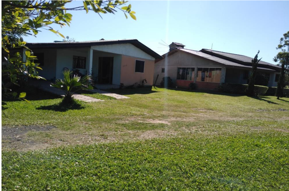
Figura 13: Aspecto das casas construídas pelo governo Lula do assentamento Santa Rita de Cássia II
