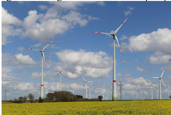
Figura 3: Aerogeradores E-101 em operação
