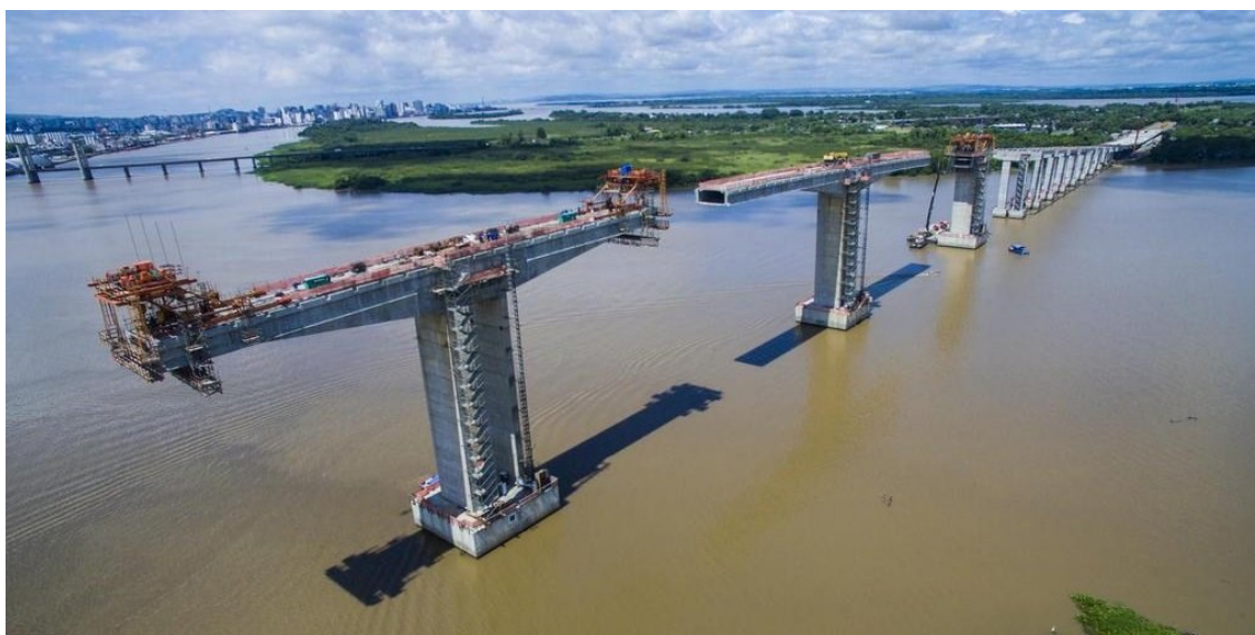
Figura 7.1 – Imagem da construção por balanços sucessivos da Nova Ponte do Guaíba
