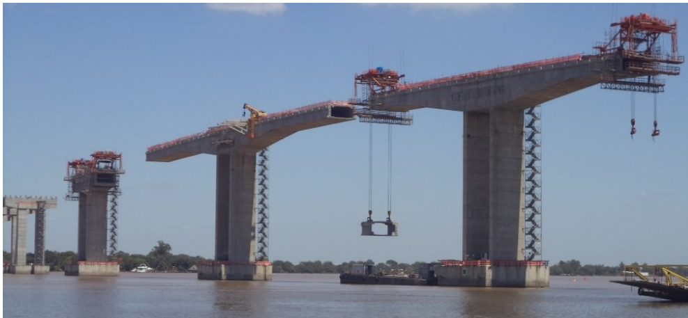
Figura 6.14 – Execução dos balanços sucessivos.
