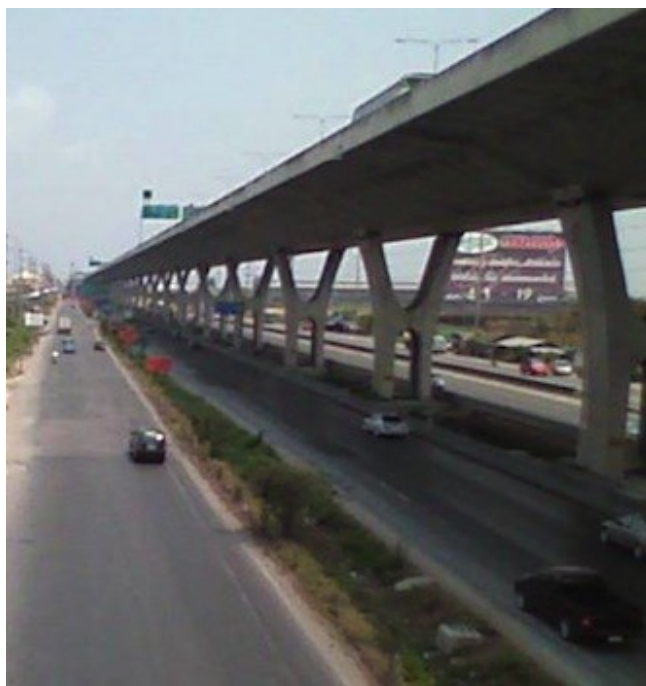
Figura 2.1 – Ponte Bang Na Expressway em Bangkok
