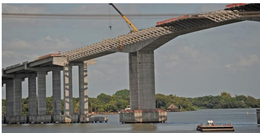
Figura 6.16 – Instalação das mãos francesas após a conclusão e fechamento dos balanços
