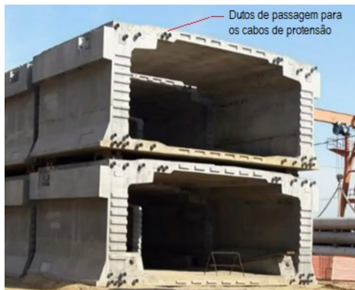
Figura 6.15 – Indicação dos dutos de passagem dos cabos de protensão internos a seção das aduelas localizados nas duas laterais da mesa de concreto
