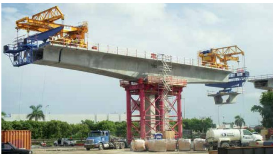
Figura 2.10 – Aduelas pré-moldadas pelo método dos balanços sucessivos
