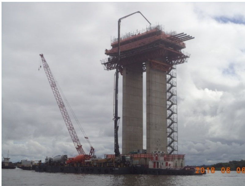
Figura 6.11 – Execução da aduela de disparo moldada in loco
