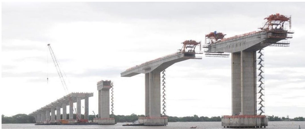
Figura 2.7 – Construção por balanço sucessivo da nova ponte do Guaíba em Porto Alegre/RS
