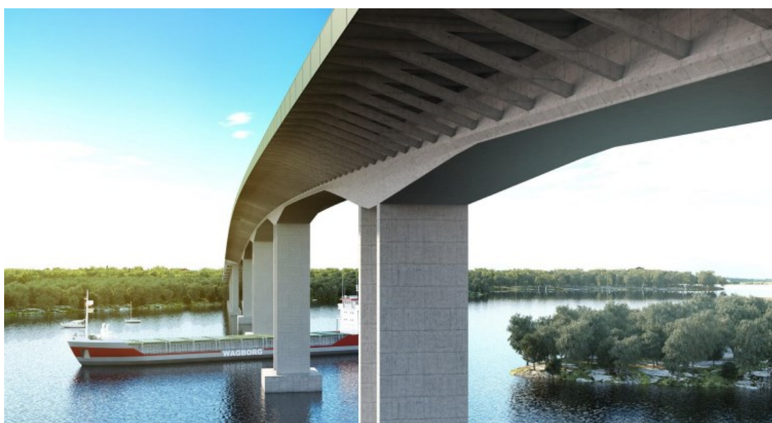
Figura 6.1– Imagem da ponte sobre os canais de navegação
