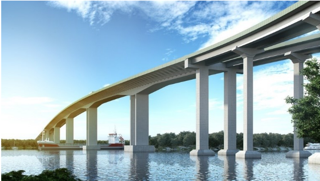
Figura 1.1 – Nova Ponte do Guaíba canal navegável
