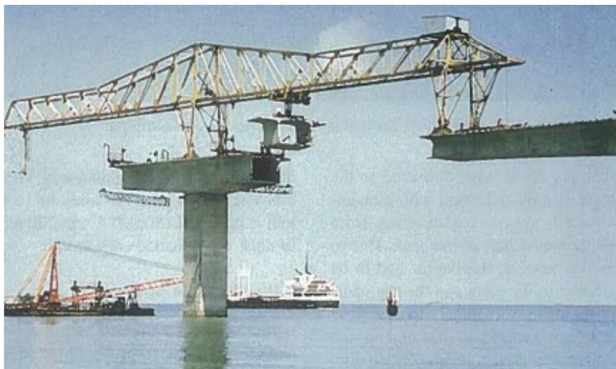
Figura 2.5 – Lançamento dos segmentos da Ponte Oléron
