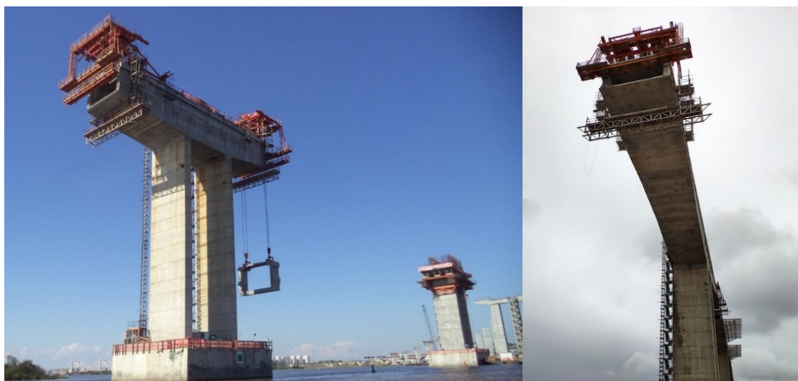
Figura 6.12 – Içamento das aduelas pré-moldadas
