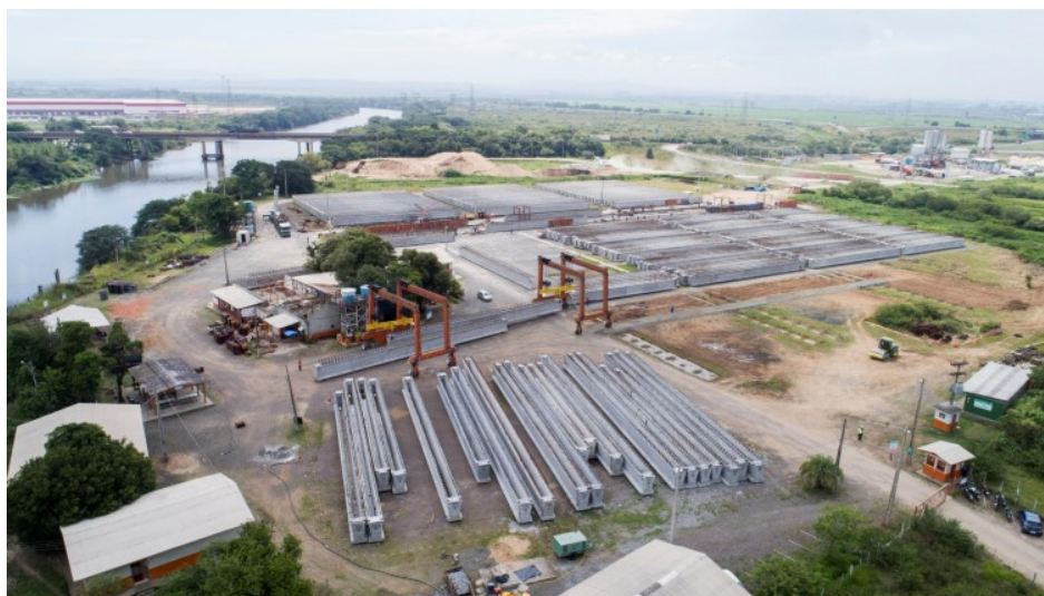
Figura 6.6–Vista do canteiro de obras da fabricação e armazenamento das estruturas pré-moldadas
