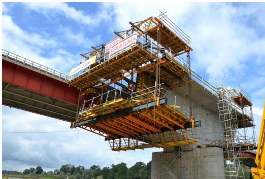
Figura 2.9 – Aduelas moldadas no local pelo método dos balanços sucessivos
