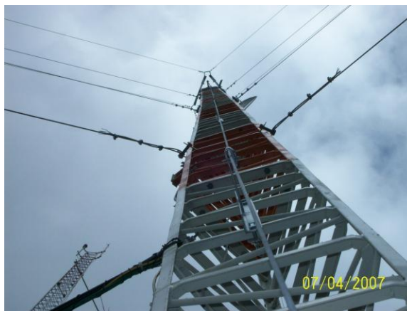
Figura 10 – Estrutura de torre estaiada
