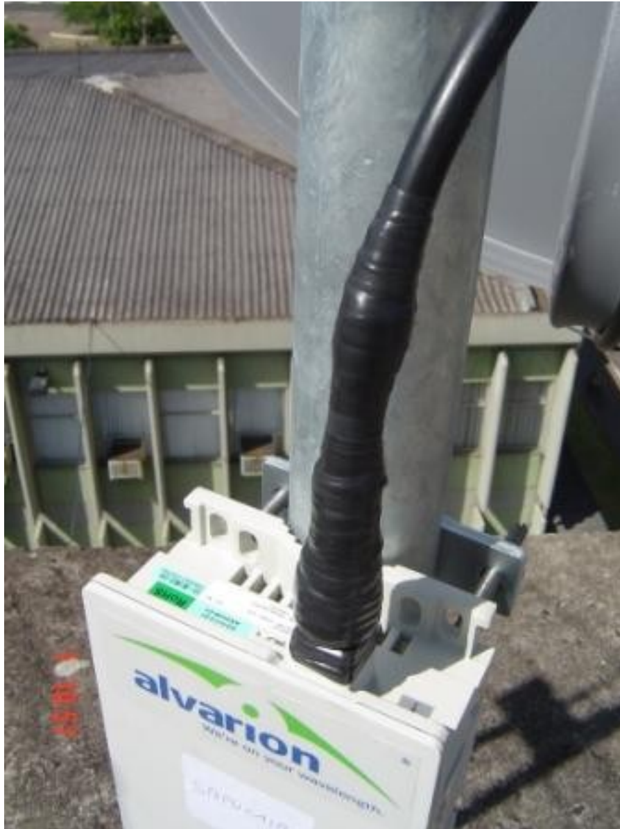
Figura 4.5 - Detalhe da aplicação correta da fita de autofusão.
