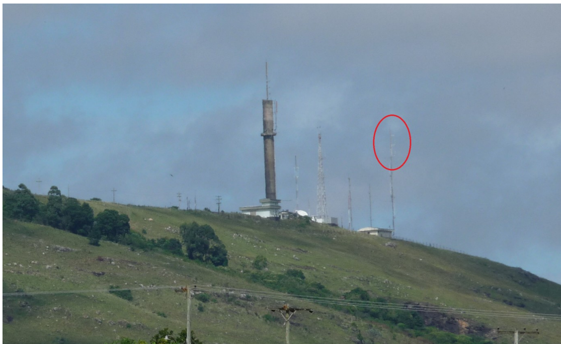
Figura 4.19 - Visada da unidade do assinante (ponto de vista do local de instalação).
