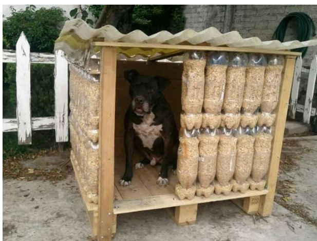
Figura 13: Casinha de garrafa PET preenchida com serragem e estrutura de madeira
