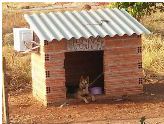
Figura 11: Casinha de alvenaria feita sob medida, in loco
