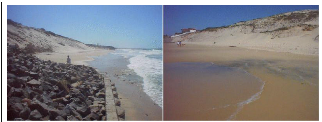
Figura 5.5. Fotografias do início da praia do Icarai, ilustrando o grande volume de material armazenado e sujeito a um gradual desmonte para suprir o que é retirado pelas ondas.
