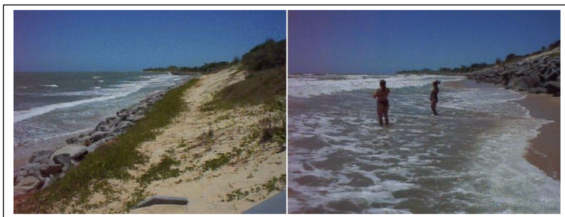
Figura 5.3. Fotografias da praia de Iparana, ilustrando as medidas adotadas para fixação da linha de costa e suas conseqüências para os banhistas.
