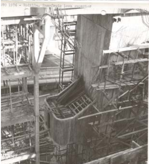
NOVIEMBRE 1976 - Vista parcial de viga de jana sobre mano y pila izquierda
