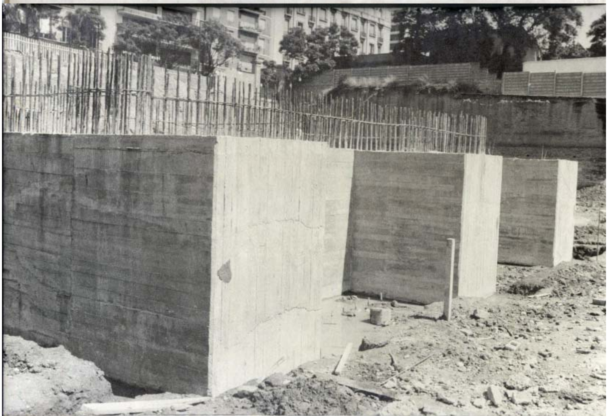
PERPECTIVA de las obras de cimentación - Los hierros que se destacan en la parte superior de las bases marcan los comienzos de las columnas maestras. Foto: 06.03.1973.
