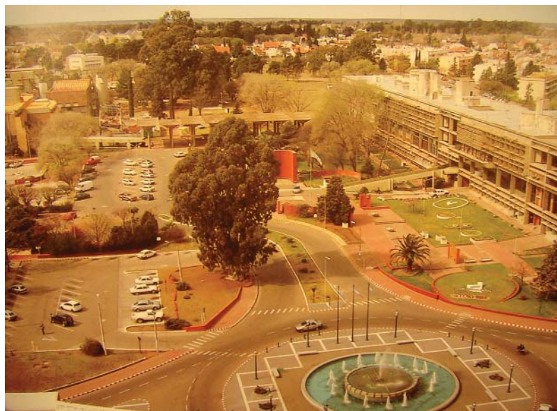
Fig. 02. Centro Cívico de Santa Rosa La Pampa, vista geral em 2005. (Fonte: Berto Gonzalez Montaner, ed., Vanguardias Argentinas. Obras y movimientos en el siglo XX. Buenos Aires, Clarín, 2005.)
