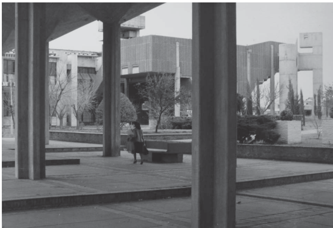
Fig. 57. Palácio Legislativo. (Fonte: Sociedad Central de Arquitectos. Buenos Aires.)
