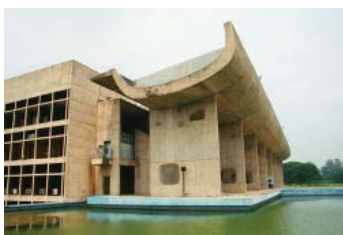
Fig. 15. Palácio da Assembléia, Chandigarh. Le Corbusier. (Fonte: disponível em www.fondationlecorbusier.asso.fr )
