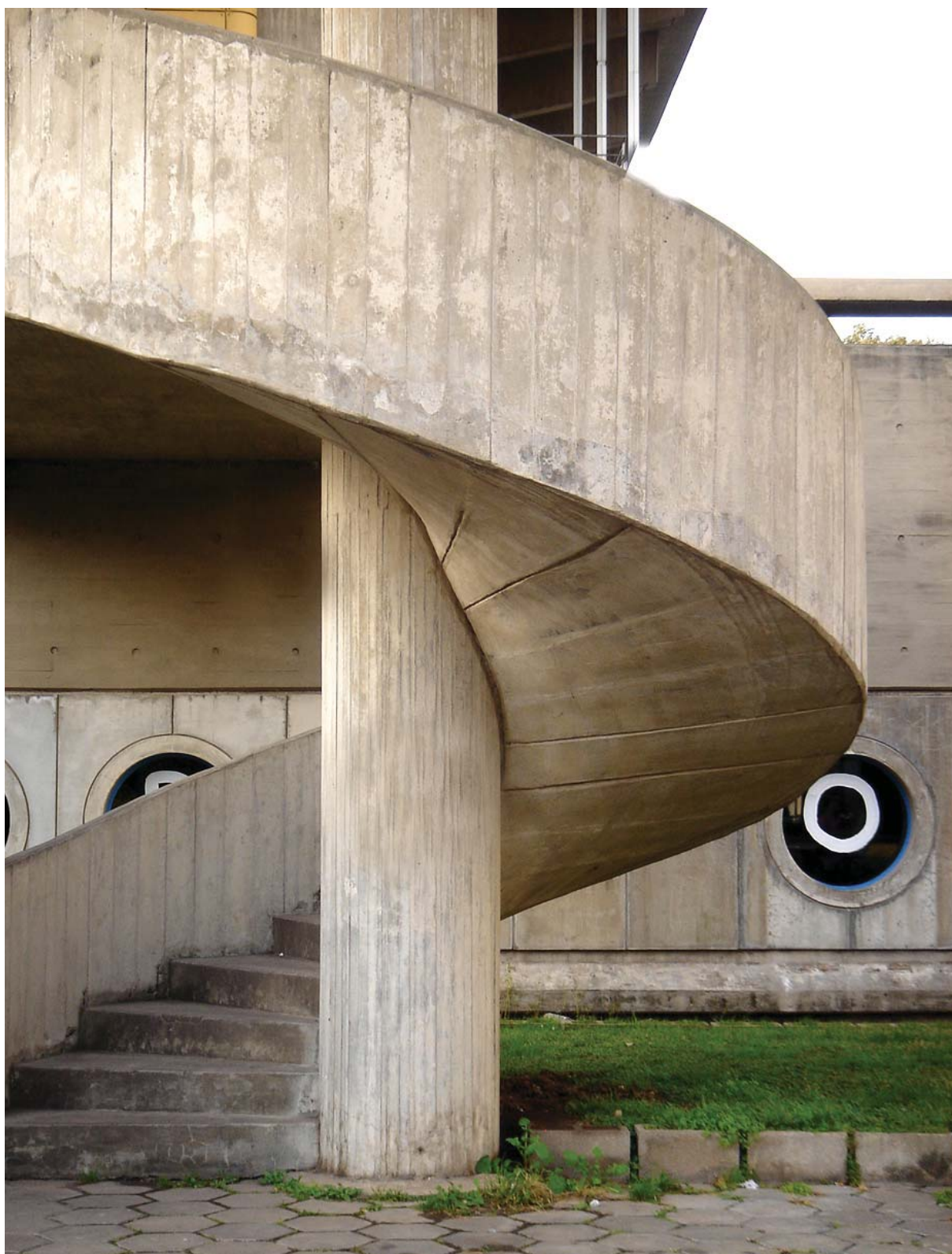
Fig. 28. Escada de acesso à esplanada, localizada paralelamente à Av. Las Heras. (Fonte: Acervo da autora, Maio 2009.)
