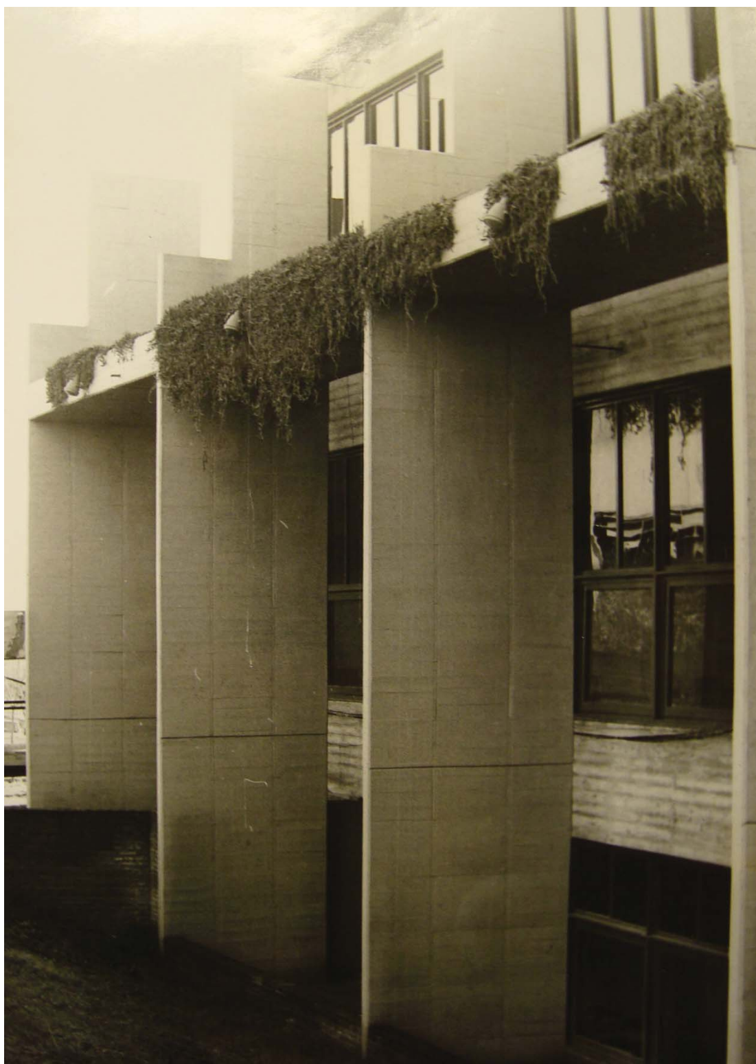
Fig. 56. Palácio Legislativo. (Fonte: Sociedad Central de Arquitectos. Buenos Aires.)
