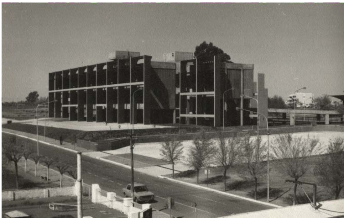
Fig. 48. Palácio Legislativo. (Fonte: Sociedad Central de Arquitectos. Buenos Aires.)
