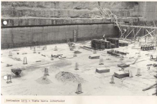
Fig. 127. Construção da Biblioteca Nacional, Novembro de 1973. (Fonte: Biblioteca Nacional.)
