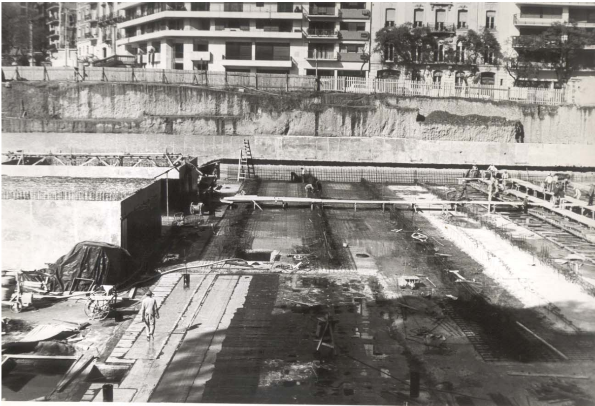
07 1973 - HORMIGONADO DE VIGAS "c" Y "d"
