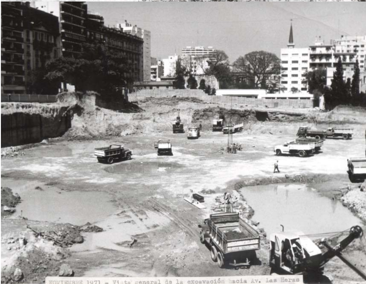
Fig. 103. Construção da Biblioteca Nacional, escavações em novembro 1971. (Fonte: Biblioteca Nacional.)
