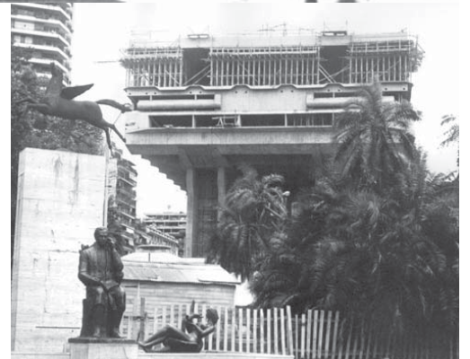
Fig. 134. Construção da Biblioteca Nacional, 1976. (Fonte: Biblioteca Nacional.)
