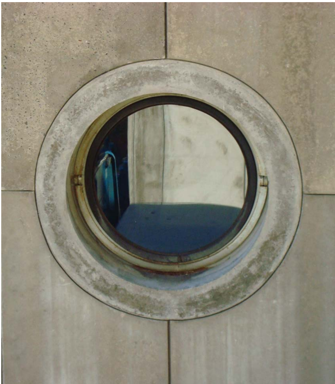
Fig. 97. Detalhe da esquadria. Biblioteca Nacional. (Fonte: Acervo da autora. Maio 2009.)
