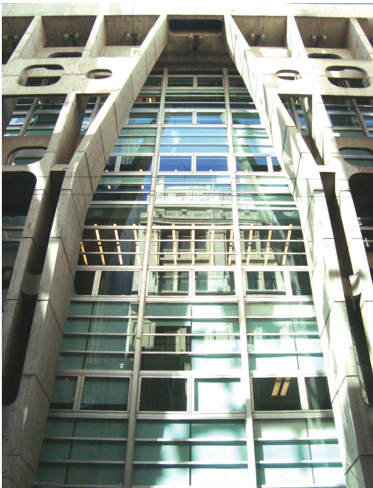
Fig. 101. Banco de Londres. Detalhe das esquadrias entre os pilares que conformam a colonata perimetral. (Fonte: Acervo da autora. Maio 2009.)
