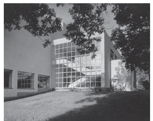
Fig. 44. Biblioteca em Viipuri, de Alvar Aalto. (Fonte: Disponível em www.alvaraalto.fi/viipuri )
