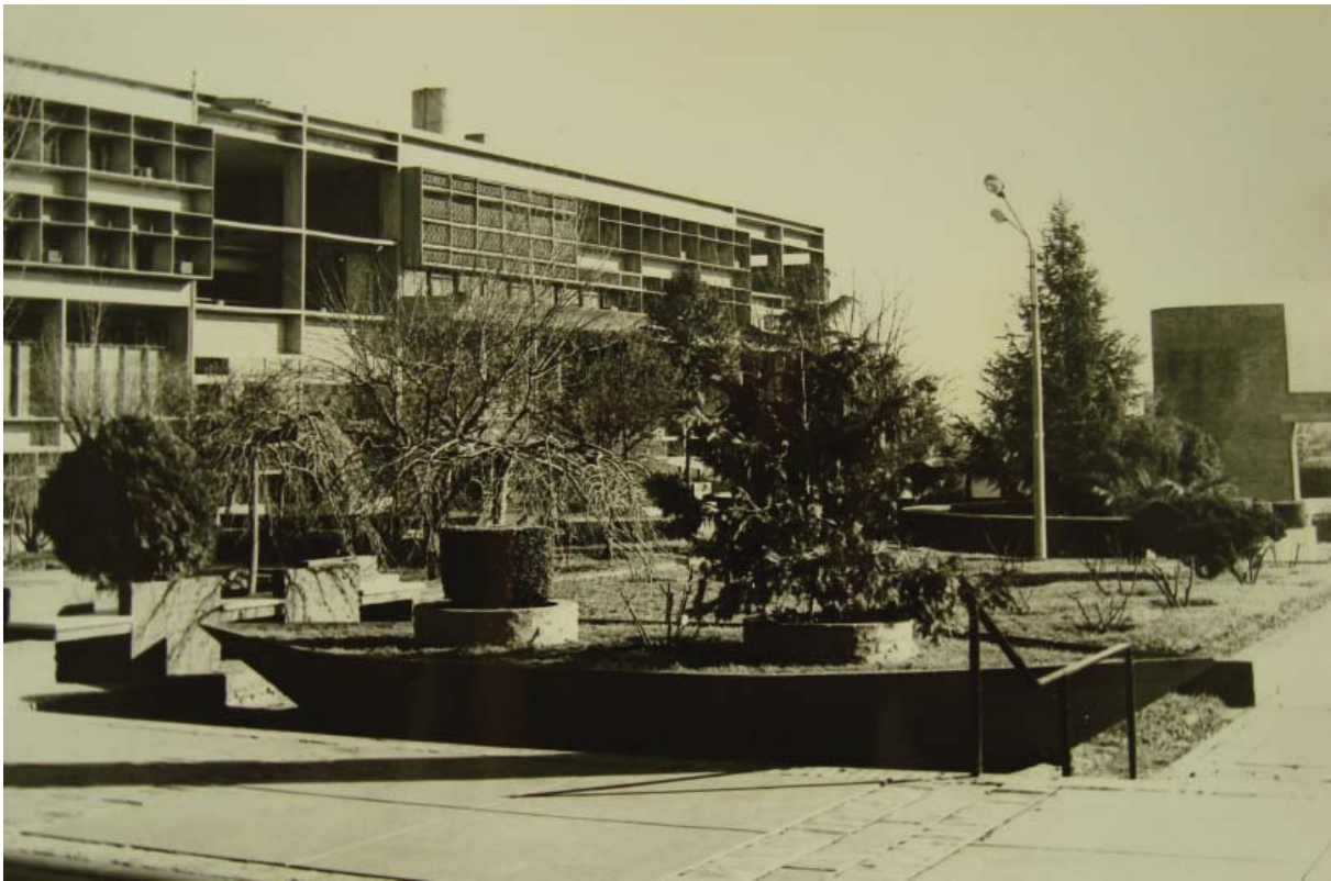
Fig. 55. Casa de Governo. (Fonte: Sociedad Central de Arquitectos. Buenos Aires.)
