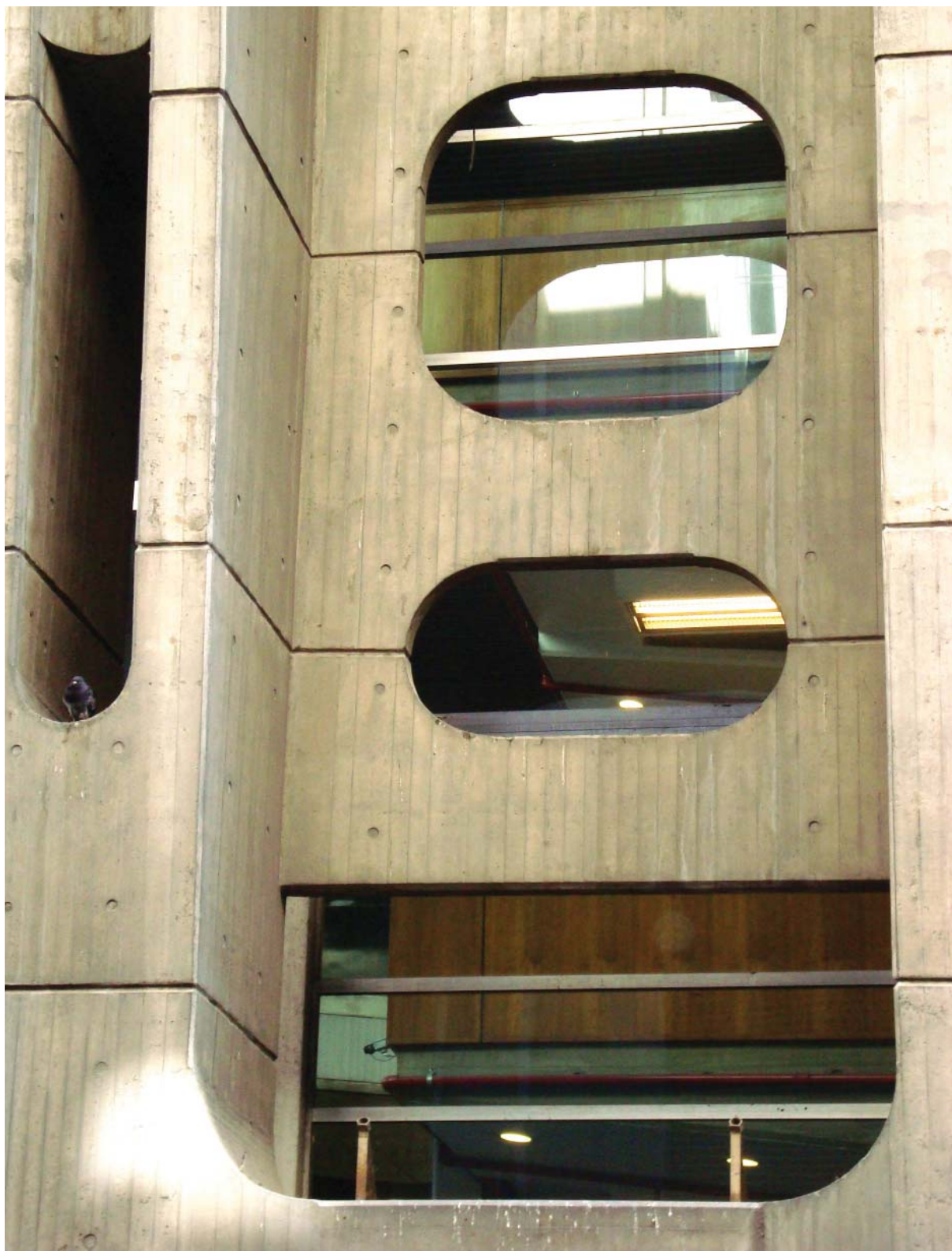
Fig. 69. Banco de Londres. Detalhe da malha externa de concreto. (Fonte: Acervo da autora. Maio 2009.)
