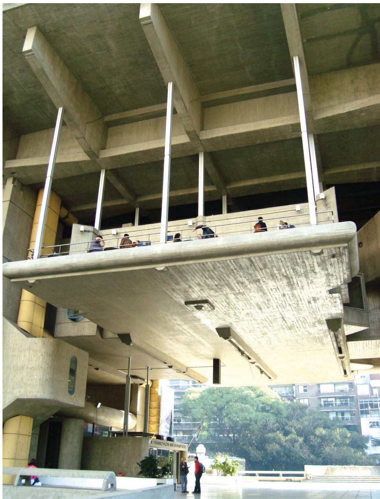
Fig. 39. Estrutura suspensa – 1º e 2º pavimentos. (Fonte: Acervo da autora. Maio 2009.)
