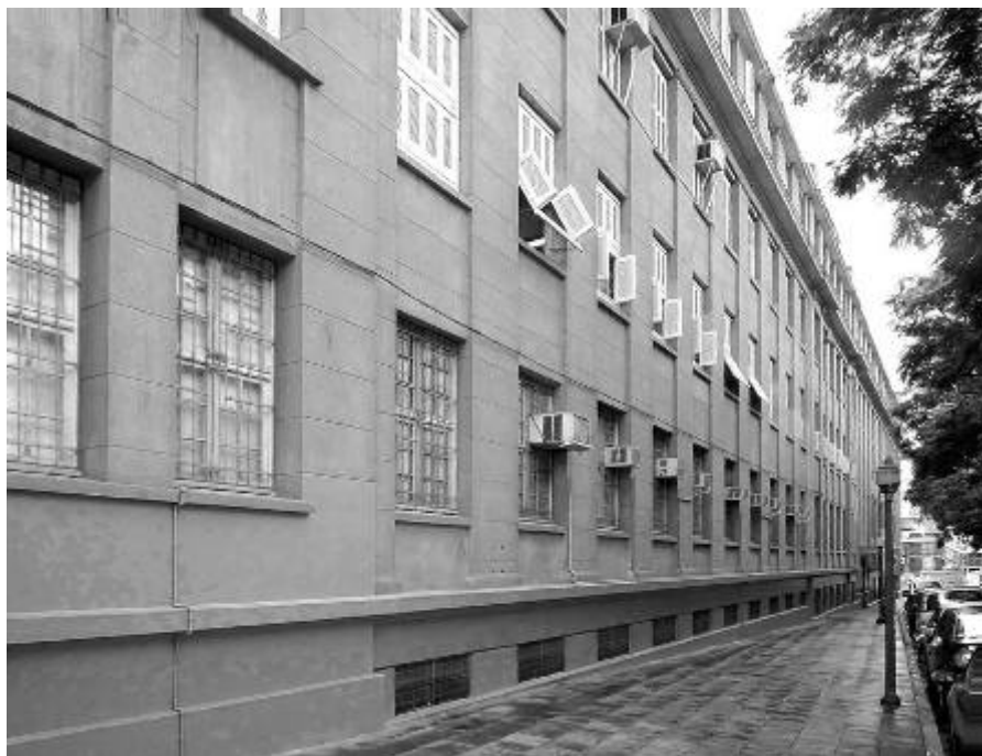
Figura: 77 Colégio Marista Rosário, Porto Alegre. A fachada- quarteirão mostra o ritmo com distintas aberturas. Foto: autor (2008)
