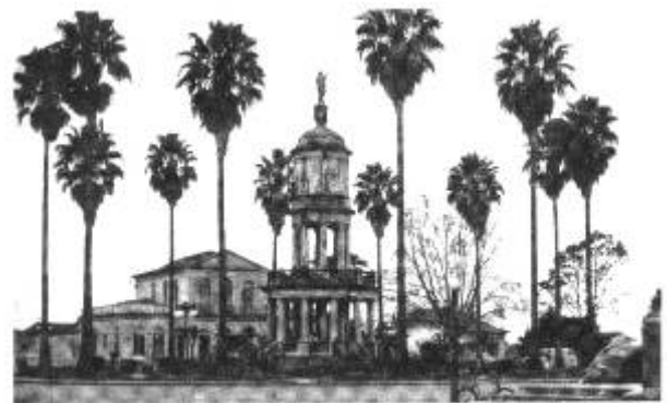
Figura: 160 Praça Balthazar de Bem, Cachoeira do Sul, década de 50, já com as palmeiras-da-Califórnia. Ao fundo a Prefeitura Municipal em estilo neoclássico. Foto: Walter Teixeira
