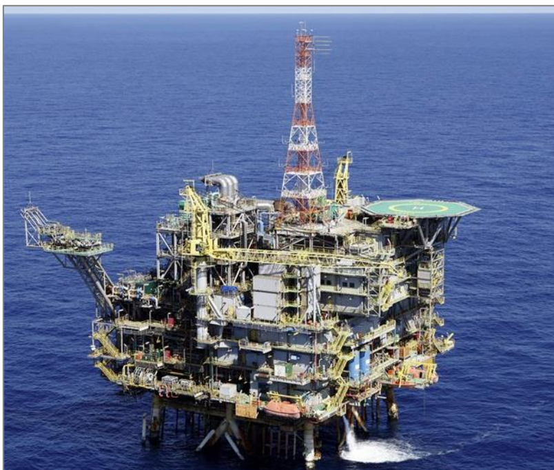
Figura 5: Plataforma fixa de Mexilhão na Bacia de Santos.
