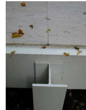
Figura 13. Casa Farnsworth (pilar em aço: forma “H”), 1945
