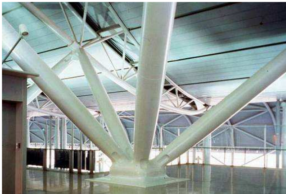
Figura 31. Piano, Aeroporto de Kansai, Apoios da Cobertura, 2000
