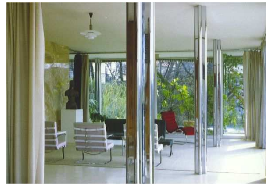
Figura 12. Casa Tugendhat (pilar em aço: forma cruciforme), 1928
