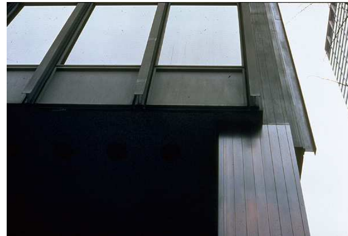
Figura 11. Edifício Seagram (perfis tipo “I”)
