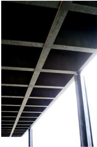
Figura 12. Junção cobertura e pilar
