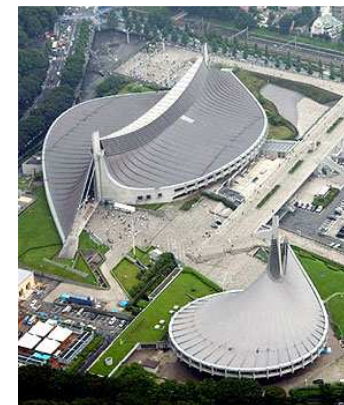
Figura 16. Tange, Cobertura das Piscinas de Tóquio, 1966
