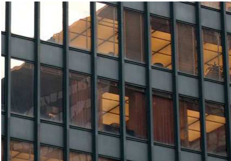
Figura 12. Edifício Seagram (parede-cortina)
