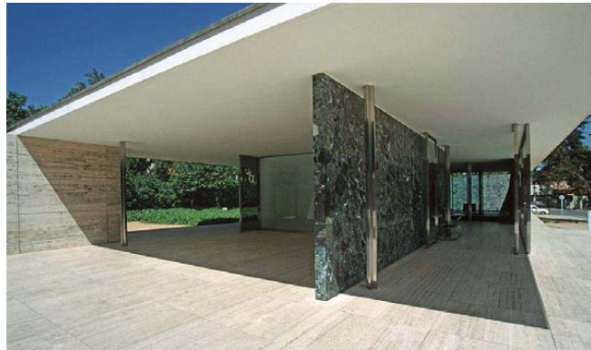
Figura 17. Os pilares cromados e a cobertura
