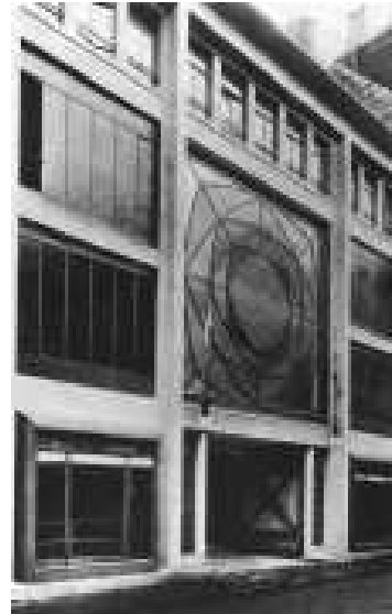
Figura 3. Perret (garagem), Paris, 1903
