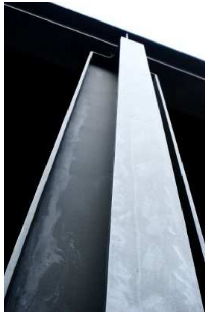
Figura 13. Pilar metálico cruciforme
