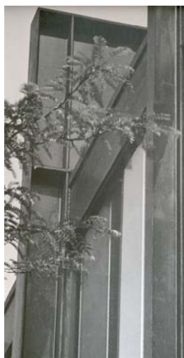
Figura 9. Pilar e viga de travamento, 1952
