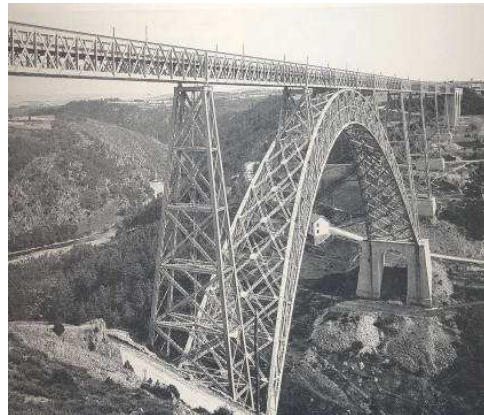
Figura 10. Eiffel, Viaduto Garabit, 1880
