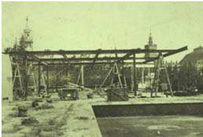
Figura 8. Cobertura (vigas metálicas), foto de 1929
