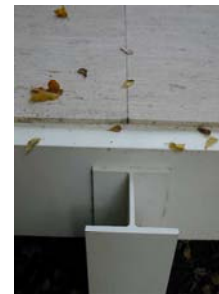
Figura 14. Pilar em “H” e viga perimetral
