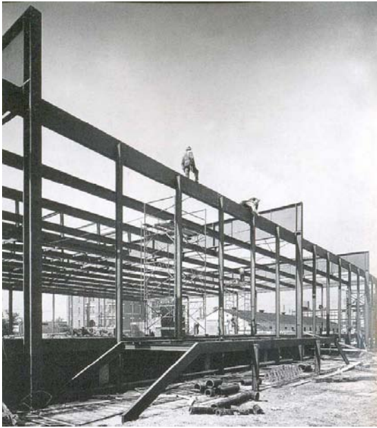
Figura 11. Crown Hall (estrutura em aço), 1952
