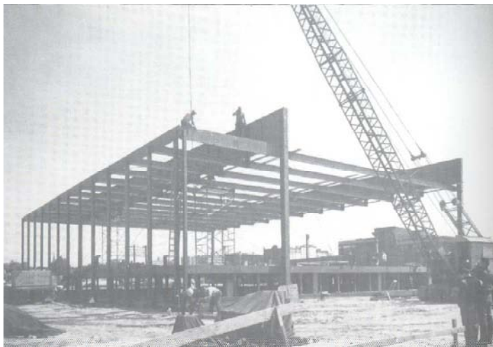
Figura 7. Crown Hall , Montagem da Estrutura, 1952.
