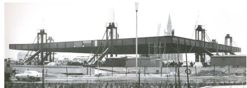
Figura 11. Cobertura suspensa por guindastes hidráulicos, 1967
