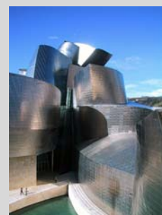
Fig. 270 Museu Guggenheim – Bilbao Espanha Arquiteto Frank Gehry
