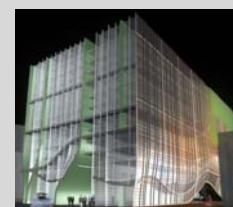
Fig. 157 V2-Lab – Vista externa
