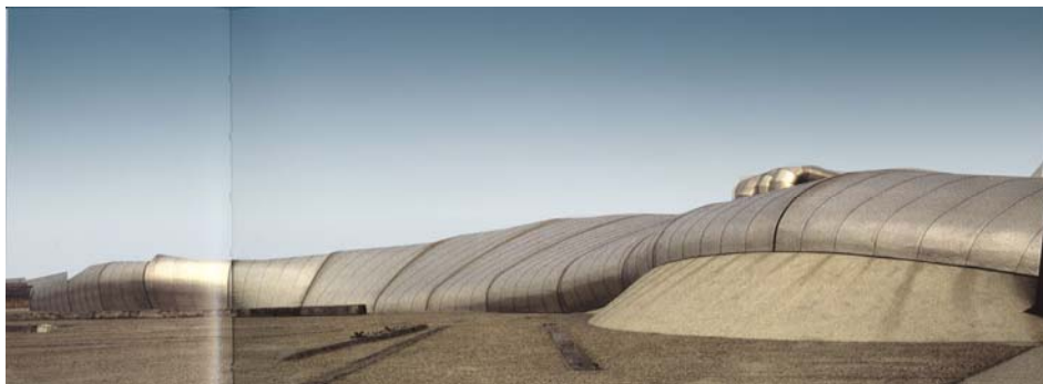
Fig. 44 H2O – Vista externa
