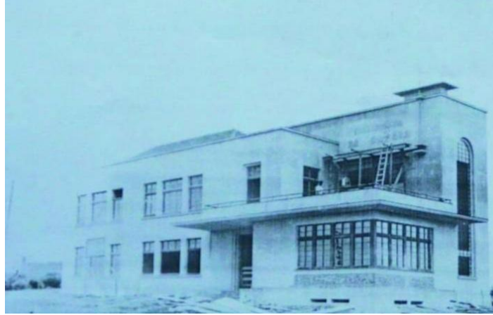
Figura 5 – Construção da Escola Mauá
