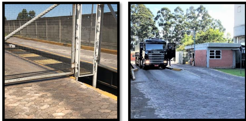
Figura 7: balança de pesagem de caminhões; Figura 8: caminhão em pesagem.
