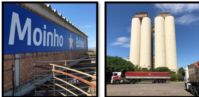
Figura 1: área externa do topo dos silos de grãos de trigo; Figura 2: visão externa dos silos da empresa.
