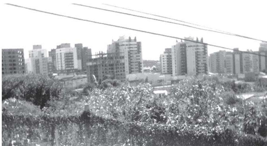
Ilustração 7: Em 2005, avançam construções sobre a antiga vila.
