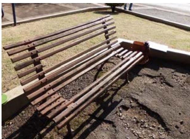
Fig.19: Piso irregular e banco quebrado. Fonte: Autor, 2016.
