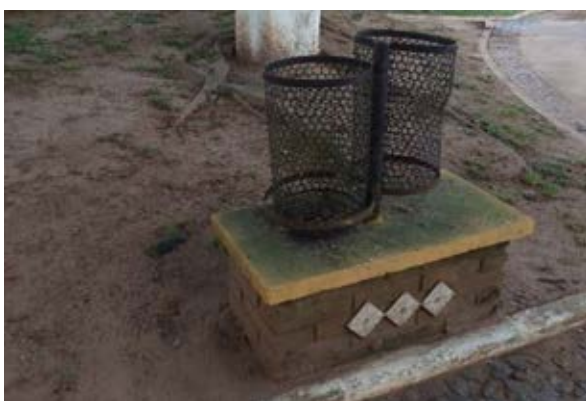
Fig.26: Lixeiras sobre base de laje e alvenaria. Fonte: Autor, 2019.
