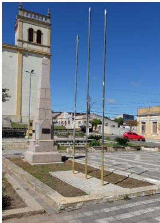
Fig.61: Espaço onde deveria estar o espelho d’água com areia. Fonte: Autor, 2021.
