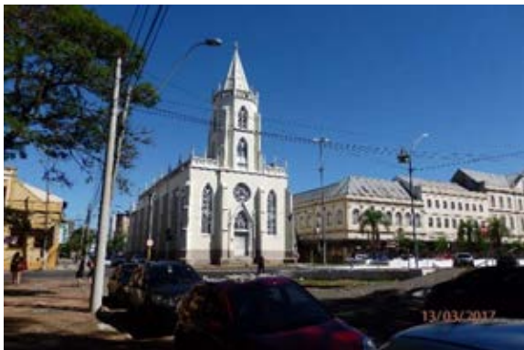
Fig.36: Acesso fechado da Igreja Matriz, Seminário Central e acesso ponte. Fonte: Autor, 2017.
