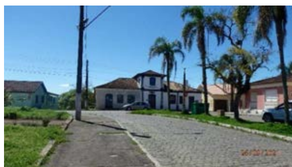
Fig.47: Vista atrás da igreja. Casa de Camarinha. Fonte: Autor, 2021.
