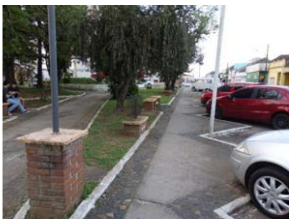
Fig.41: Bases sem manutenção. Fonte: Autor, 2019.
