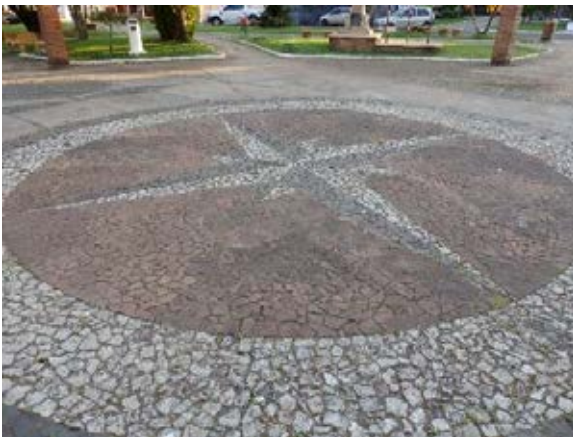
Fig.33: Pavimentação em pedra portuguesa. Fonte: Autor, 2019.
