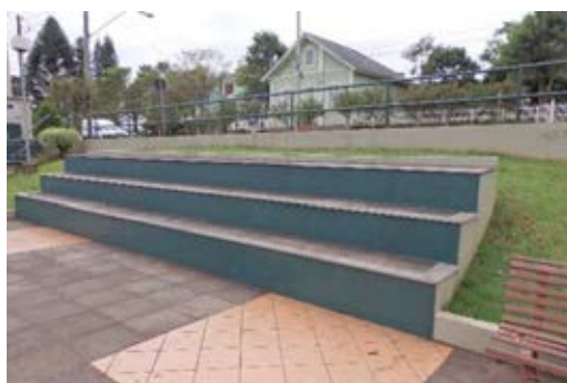
Fig.12: Arquibancada Fonte: Autor, 2016.
