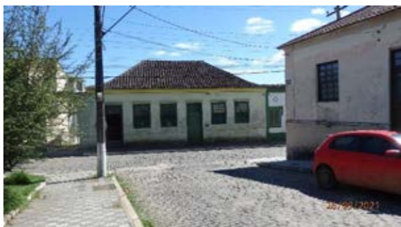
Fig.44: Vista Esquina 20 de Setembro e R. Gen. Bento Gonçalves a partir da Praça. Fonte: Autor, 2021.
