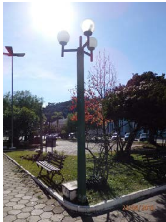
Fig.48: Poste de iluminação, 2018. Fonte: Autora, 2018.
