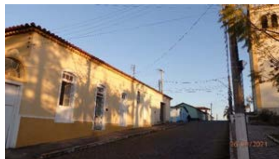
Fig.59: Casa Comercial Fabião. Fonte: Autor, 2021.
