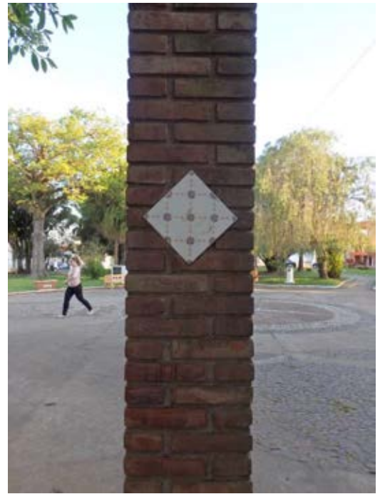
Fig.32: Aplicação no arco. Fonte: Autor, 2019.
