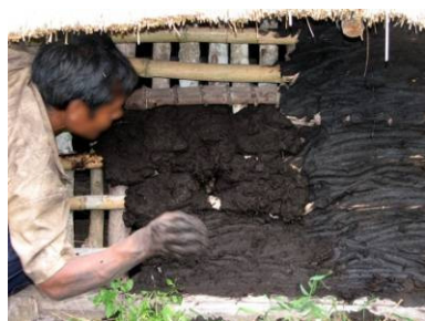
Figura 105: Aplicação de barro sobre o pau-a-pique
