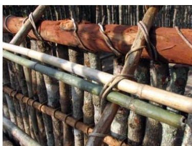
Figura 79: Enlaçamento com cipó
