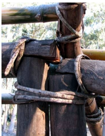
Figura 121: Amarração pilar parede
