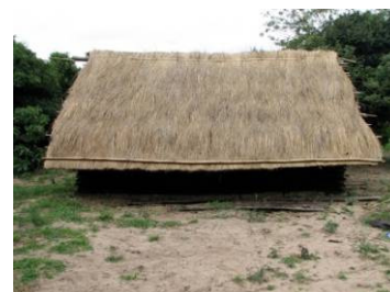
Figura 103: Vista lateral da cobertura de capim Santa Fé
