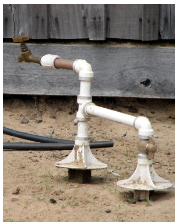
Figura 29: Torneira - Casa do Índio
