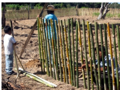
Figura 33: Execução da cerca da horta
