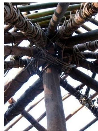
Figura 122: Amarração pilar pórtico
