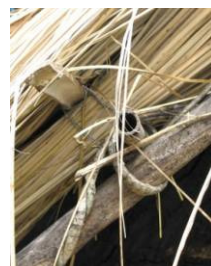
Figura 102: Amarração da cobertura de capim Santa Fé
