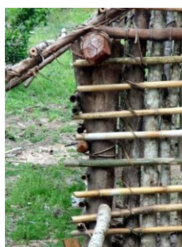
Figura 94: Transpasse nos pilares
