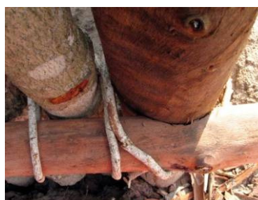
Figura 81: Entalhe e enlaçamento
