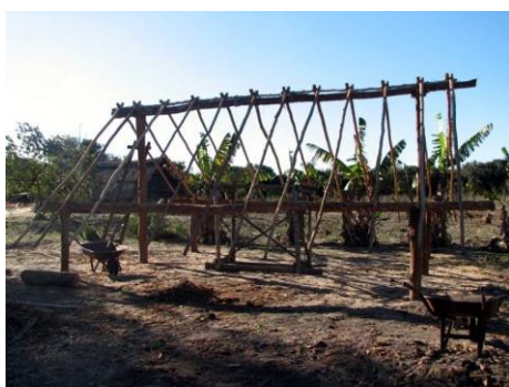
Figura 85: Estrutura de madeira - Caibros
