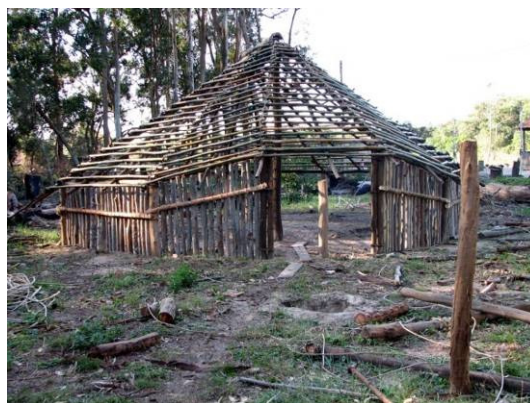
Figura 119: Estrutura de madeira
