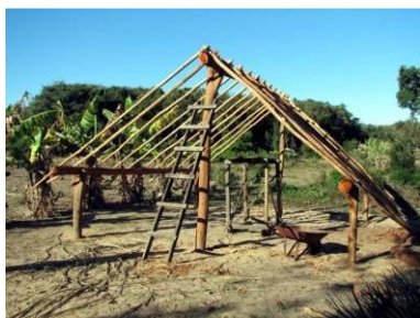
Figura 84: Estrutura de madeira
