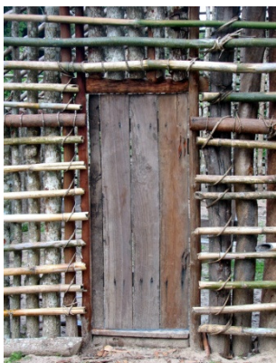
Figura 67: A porta da construção
