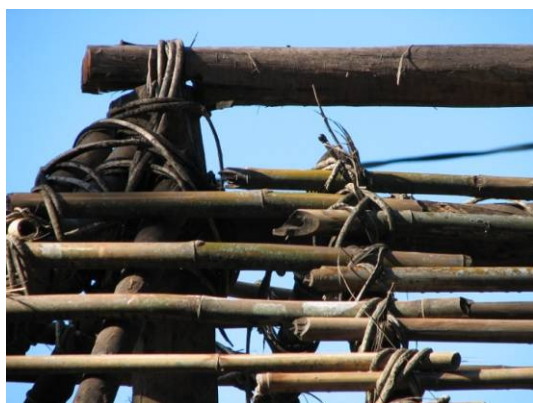
Figura 123: Estrutura da cobertura
