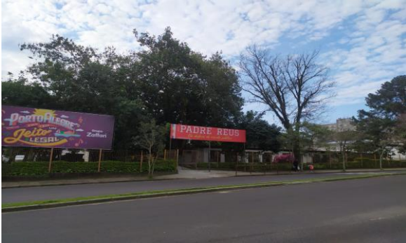
Foto 1: Fachada da Escola
