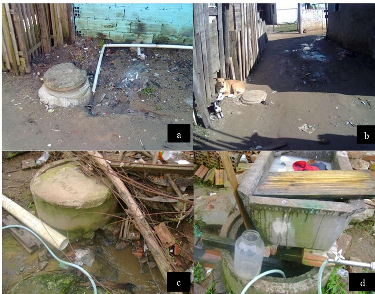
Figura 2.7 - Exemplos de mau uso da rede de coleta dos esgotos sanitários do tipo separador absoluto: a) PV quebrado para lançamento de água de pia; b) PV quebrado para escoar água de chuva; c) PV quebrado para escoar água de vertente; d) PV usado para apoiar um tanque, onde a água da torneira corria continuamente.
