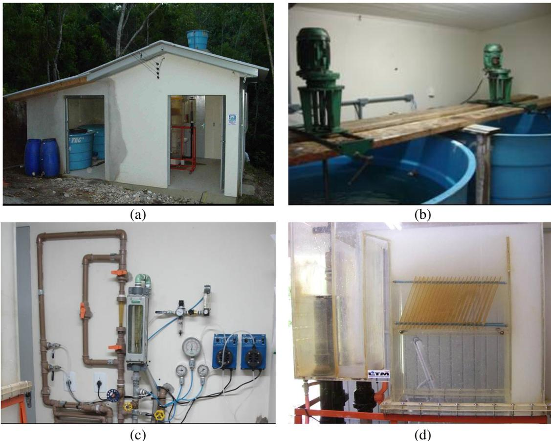
Figura 4.5 Estação piloto de tratamento de DAM-SS16-Criciúma/SC (a); Tanques de neutralização/precipitação dos íons metálicos e íons sulfato (b); Instrumentação para controle de vazão e pressão (c); Detalhe da célula FADAT (d).
