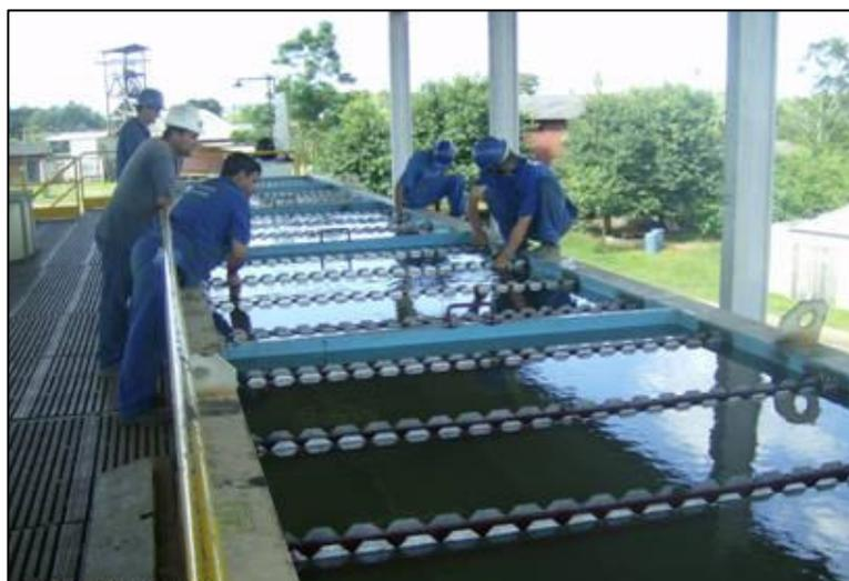
Figura 3.7 Estação de tratamento de DAM ( $250 \text{ m}^3\text{h}^{-1}$ ) instalada na carbonífera Cooperminas (SC).
