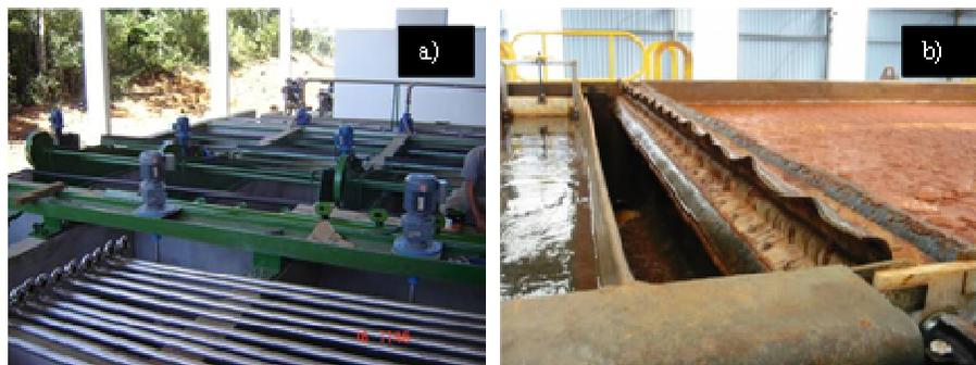
Figura 3.6 (a) Estação de Tratamento de águas ácidas via FAD; (b) Aspecto do lodo flotado em células FAD. Carbonífera Metropolitana S.A. (SC).
