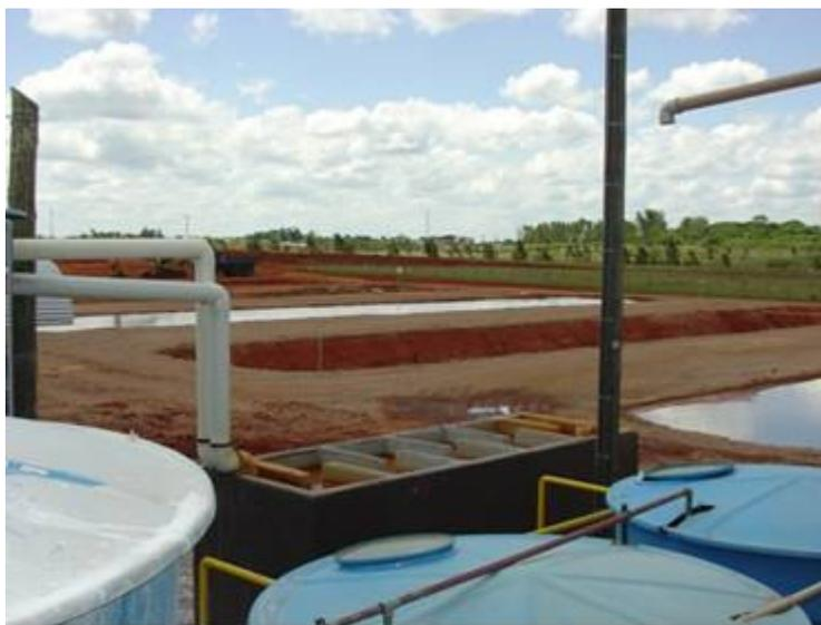
Figura 3.3 Bacias de sedimentação de flocos de DAM tratada (NF) e detalhe do sistema de floculação (chicanas de fluxo hidráulico horizontal) – Capão da Roça, COPELMI/RS.
