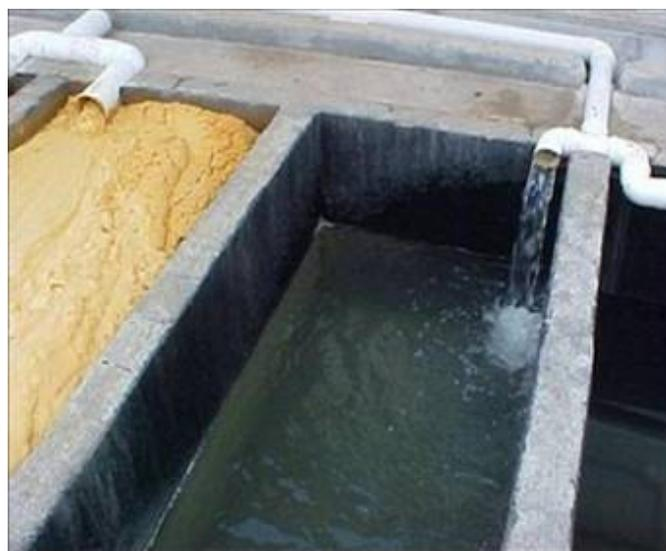
Figura 3.5 Aspecto do lodo flotado e da água tratada pelo processo NF-FAD, Carbonífera Metropolitana S.A (SC).
