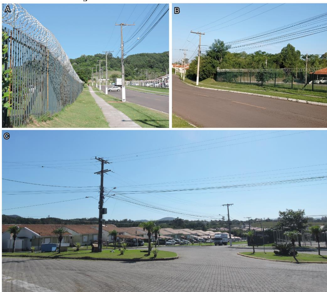
Figura 38 - Acesso ao condomínio Terra Nova
