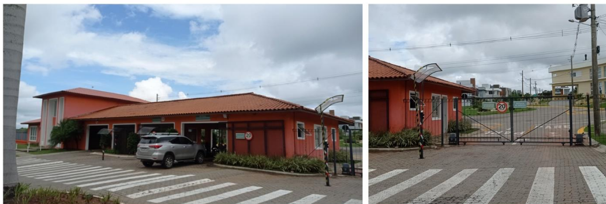
Figura 30 - Pórtico de Acesso ao condomínio Real Park
