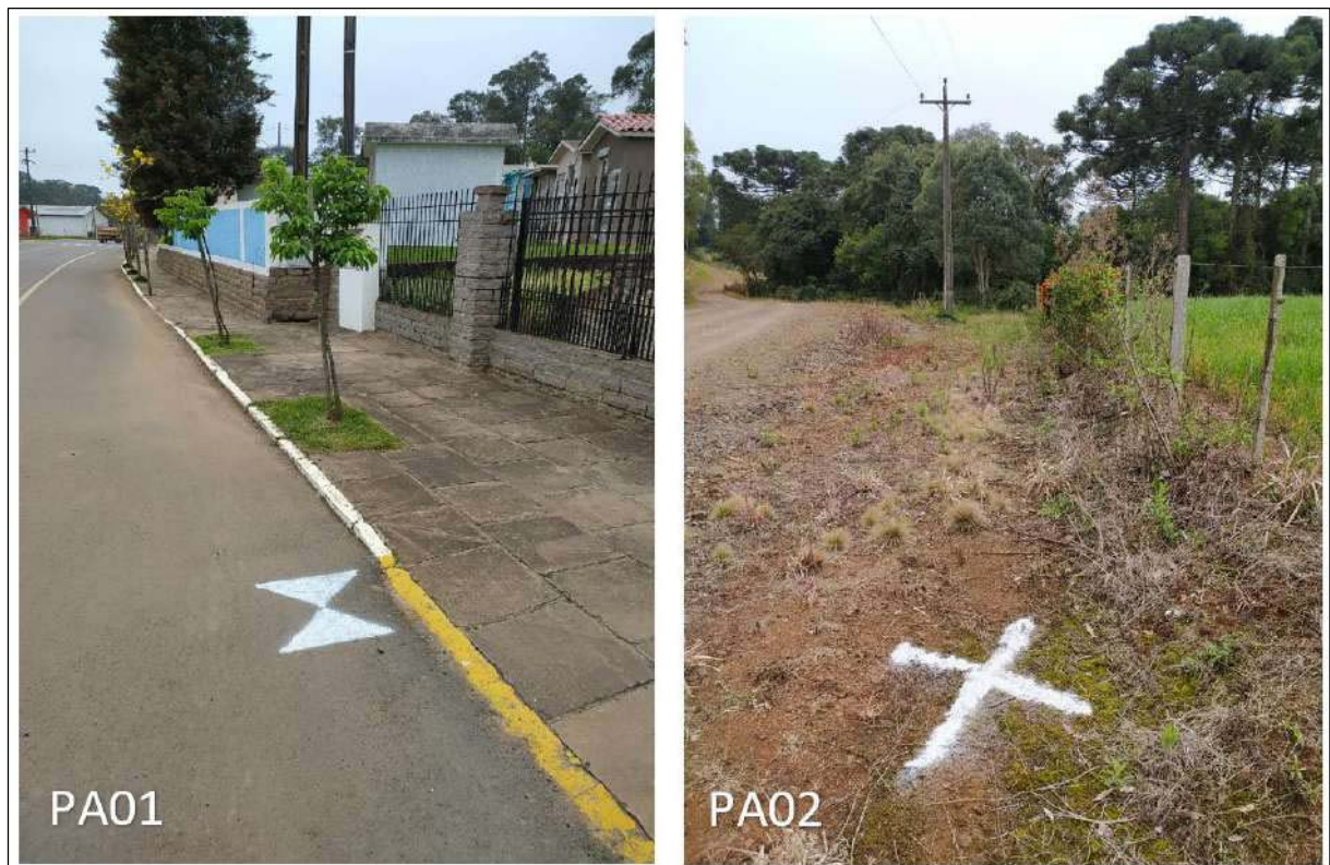
Figura 14 - Exemplos de alvos para sinalização de pontos de apoio e checagem
