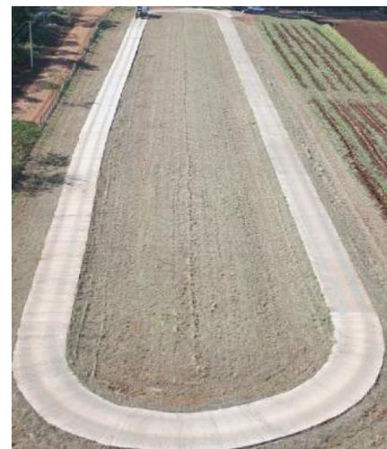
Figura B. 1 – (a) Perfil de pista lisa da NBR ISO 5008(2015). (b) Pista Real.
