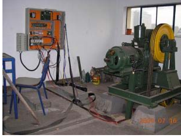
Fig. 5.6.8 Casa de máquinas.
