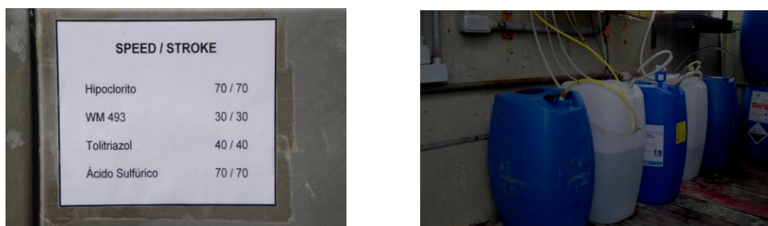
Figura 6 – Fotos dos parâmetros de regulação da dosagem e das bombonas em utilização
